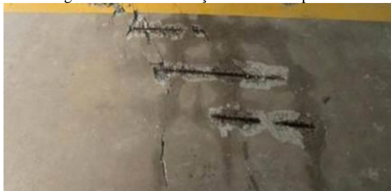
Figura 31 - Patologia Corrosão e Oxidação de um Piso por umidade ascendente
