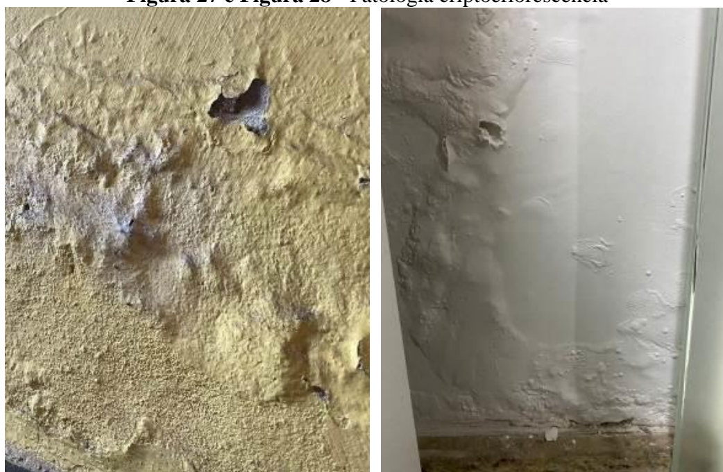
Figura 27 e Figura 28 - Patologia criptoeflorescência
