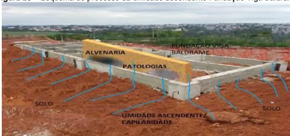
Figura 23 – Esquema do processo da umidade ascendente Fundação Viga Baldrame.
