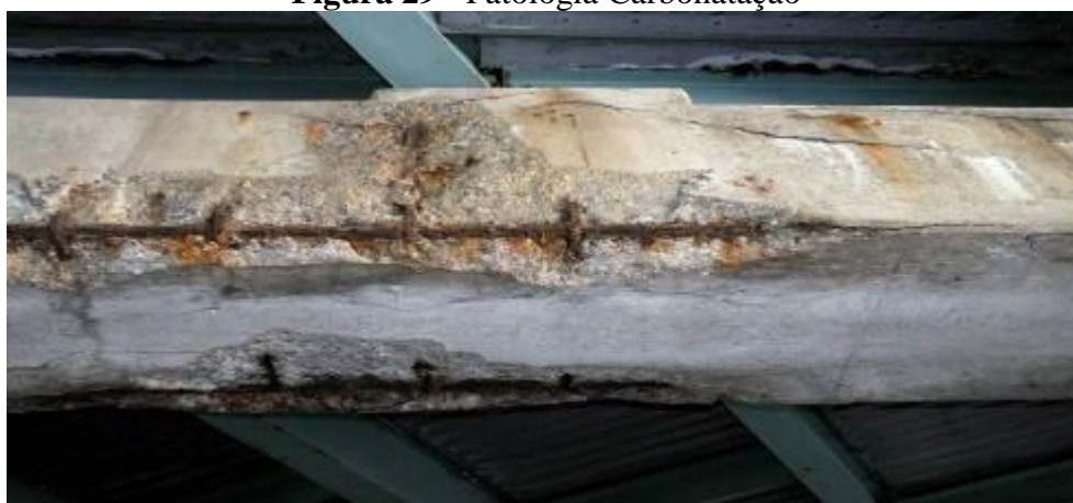
Figura 29 - Patologia Carbonatação
