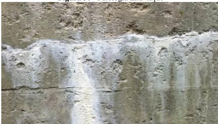
Figura 30 - Patologia Lixiviação
