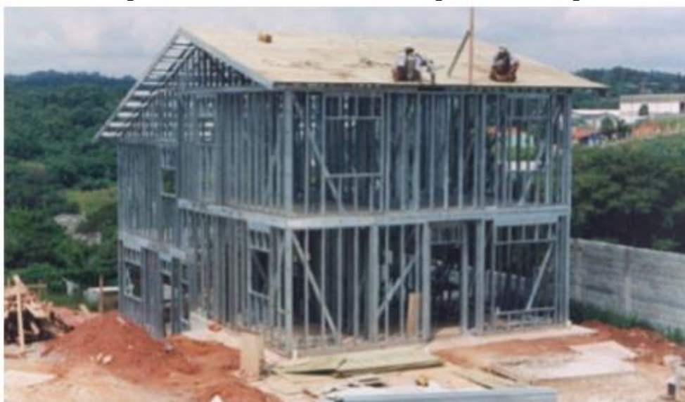
Figura 3- Estrutura de residência em Light Steel Framing .
