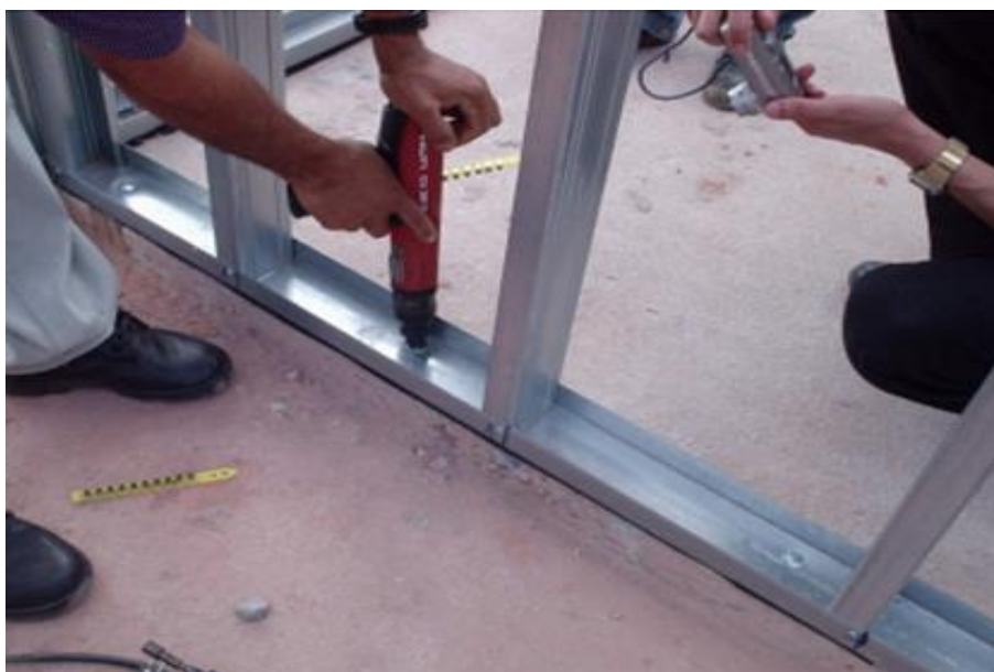
Figura 11 - Detalhe da fixação de um conector à pólvora
