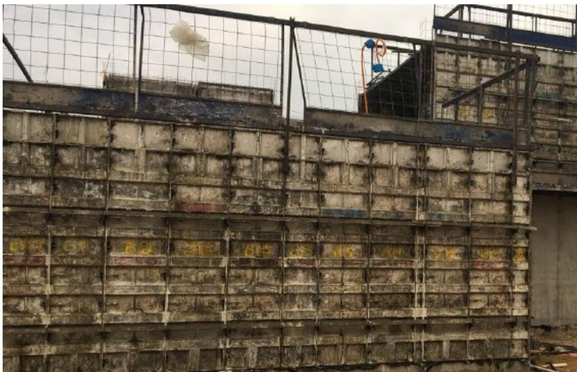
Figura 22 – Instalação das fôrmas das paredes
