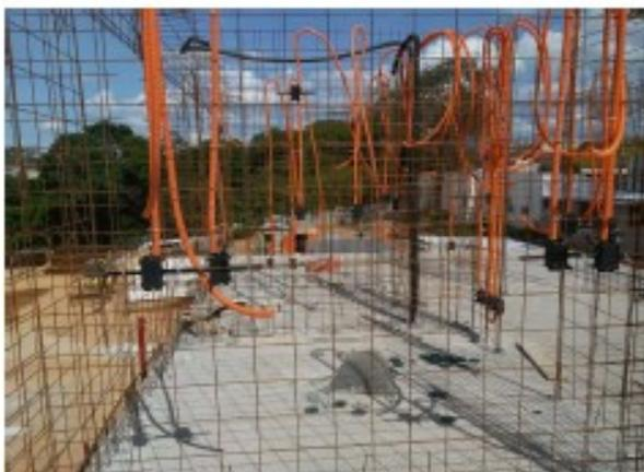
Figura 6 – Caixas Elétricas e Conduites Fixados na tela da Armação
