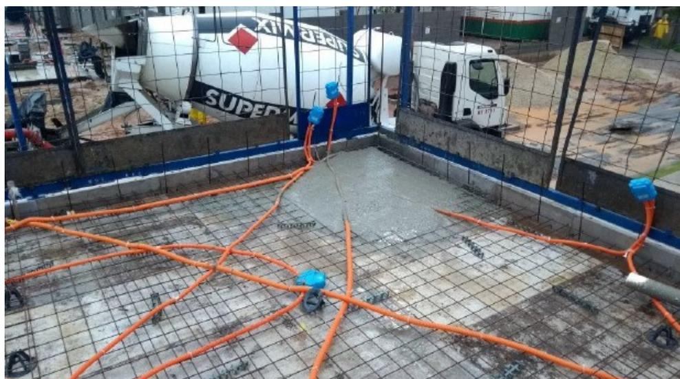
Figura 24 – Lançamento de concreto no encontro das paredes
