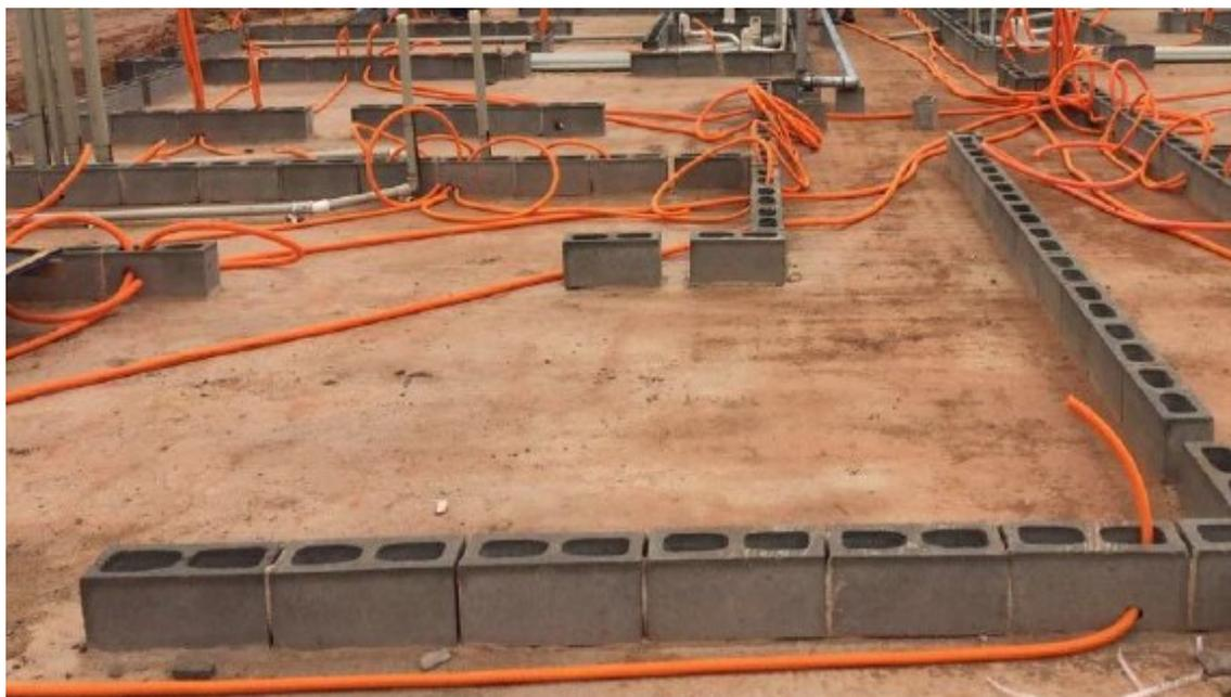
Figura 11 – Marcação alvenaria 1ª fiada
