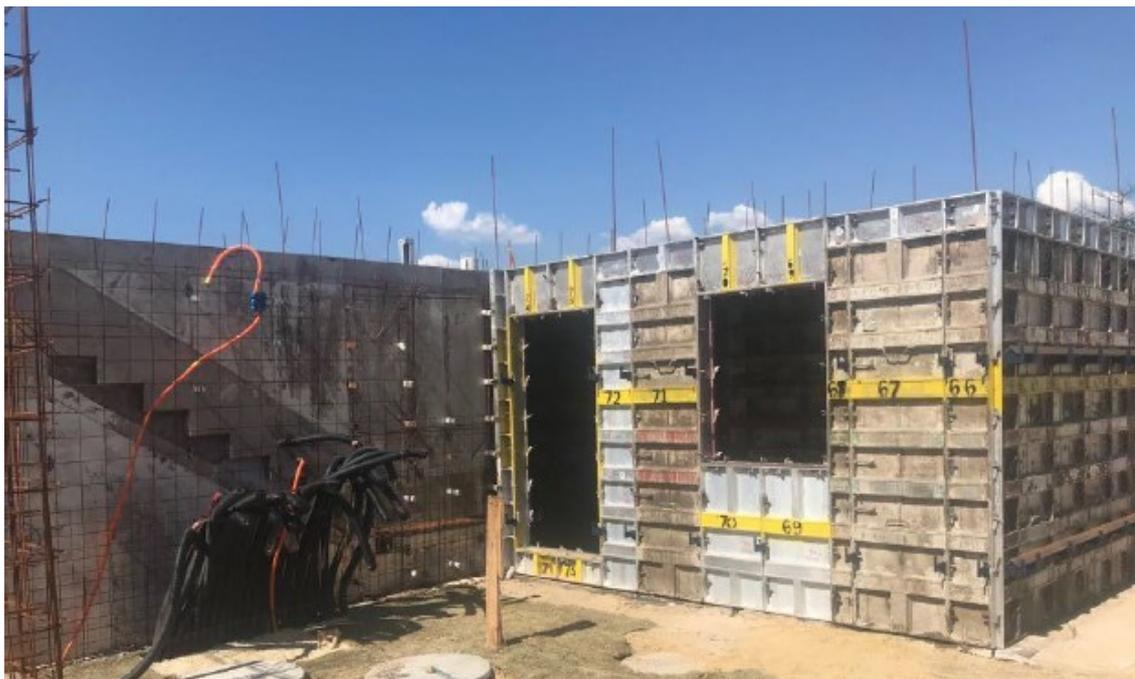
Figura 23 – Identificação das placas após a primeira montagem
