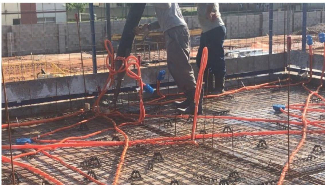
Figura 25 – Lançamento de concreto no encontro das paredes
