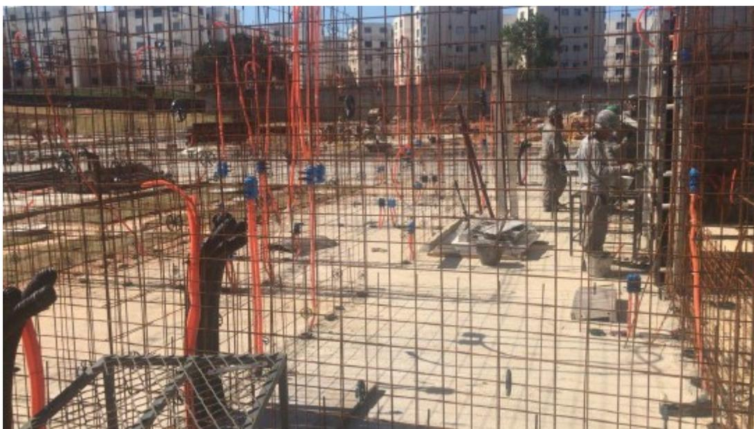
Figura 17 – Telas posicionadas e centralizadas na projeção das paredes
