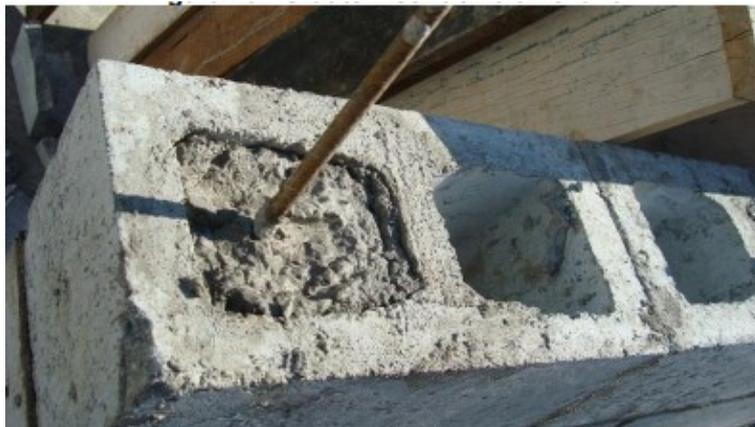
Figura 2 – Graute Inserido na Alvenaria
