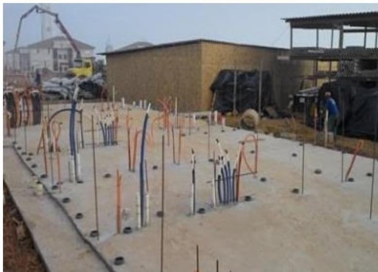
Figura 16 – Instalação dos distanciadores e dos pontos de arranques na laje
