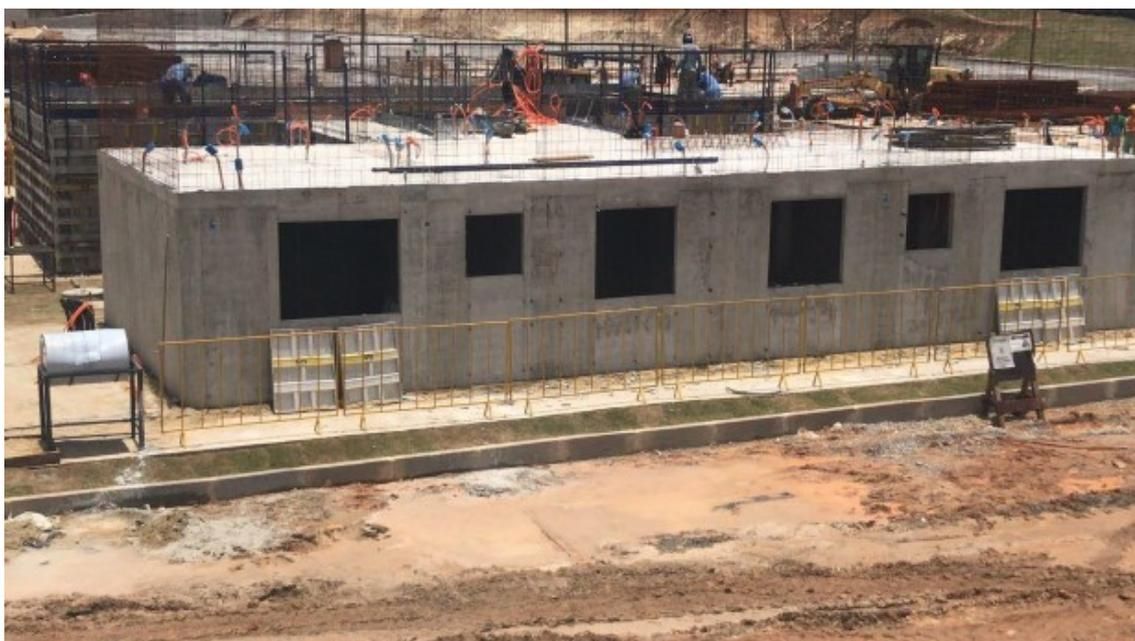
Figura 30 – Pavimento após a retirada das fôrmas
