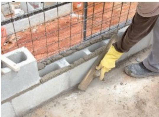
Figura 1 – Argamassa de Assentamento de Bloco de Concreto
