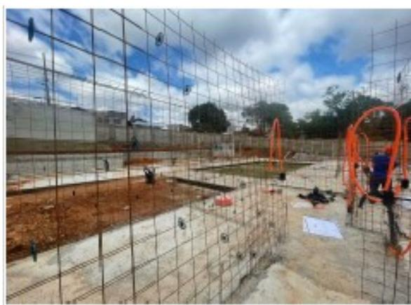
Figura 5 – Armação com Telas e espaçadores
