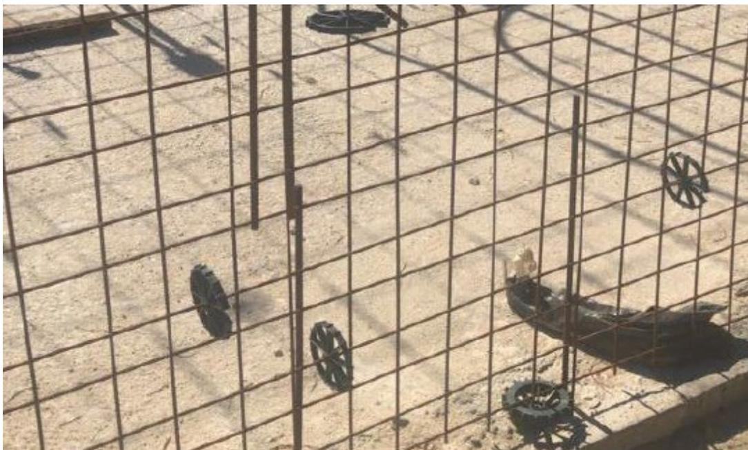
Figura 18 – Espaçadores plásticos para auxiliar na posição da armadura
