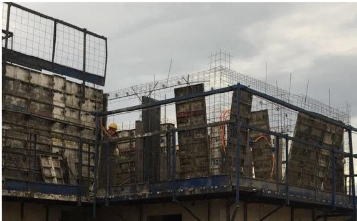
Figura 21 – Instalação das fôrmas das paredes
