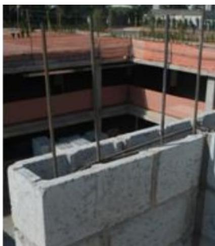
Figura 3 – Armação na alvenaria Estrutural
