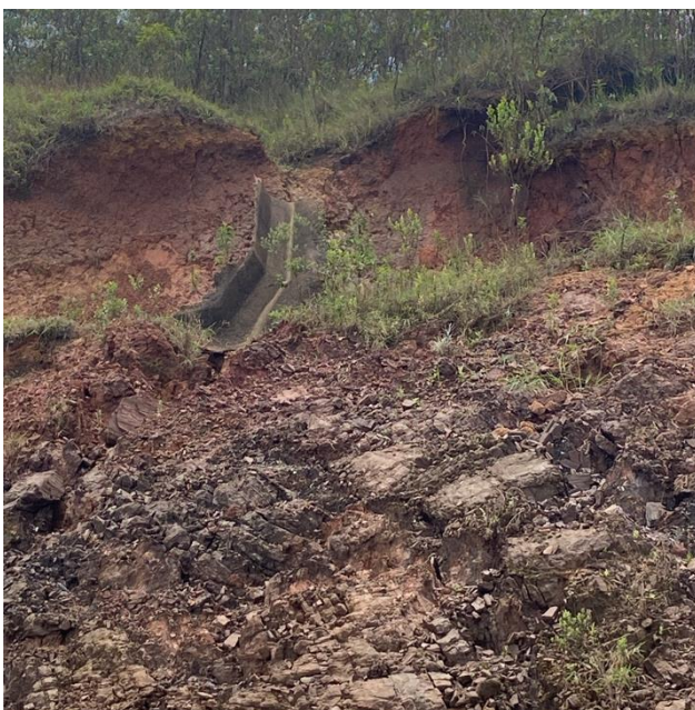
Figura 12 - Drenagem Superficial obstruída.
