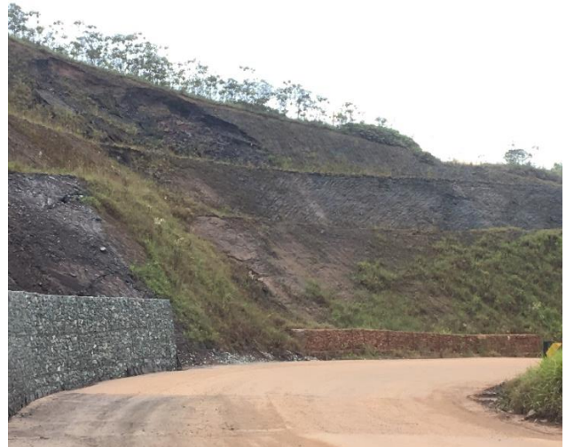
Figura 11 - a) Gabião sendo executado; b) Gabião existente.
