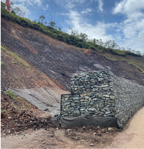
Figura 11 - a) Gabião sendo executado; b) Gabião existente.
