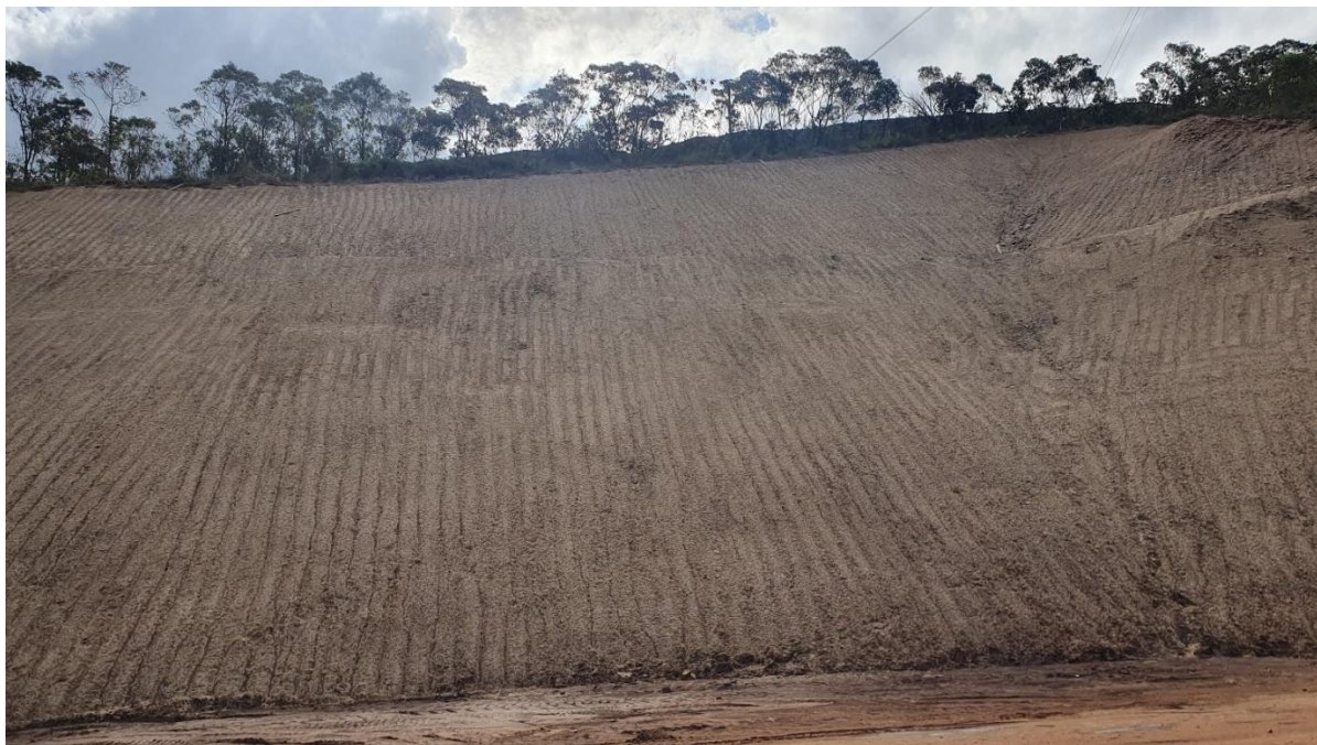
Figura 13 - Retaludamento executado em parte da área em estudo.
