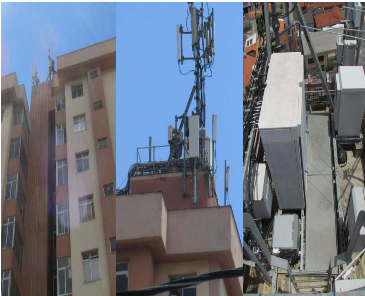
Figura 11 – Estrutura de Telhado (Rooftop)
