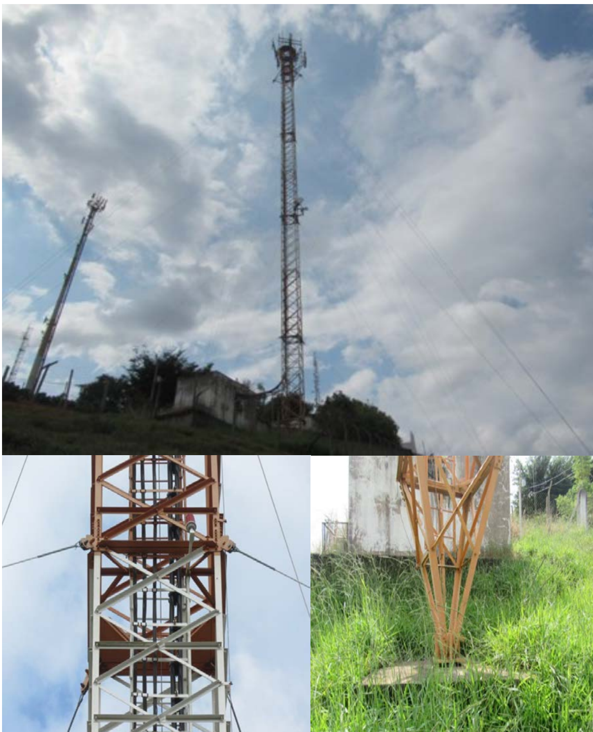
Figura 4 – Torre Estaiada Fonte – Levantamento Técnico município de Lajinha/MG
