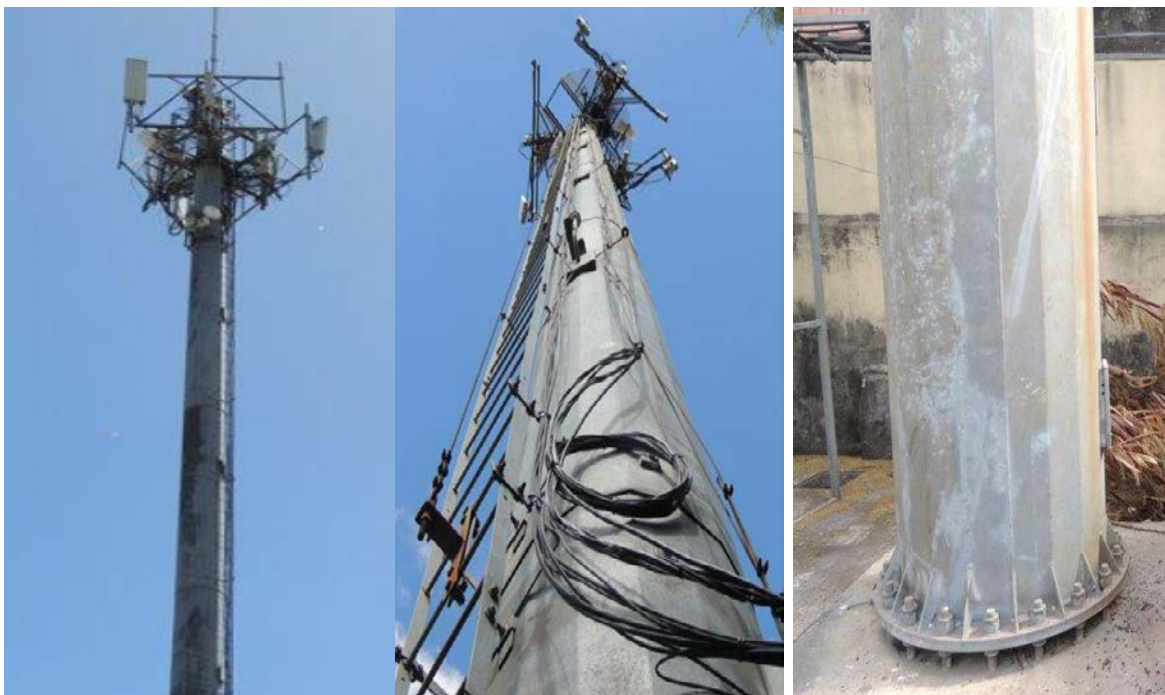
Figura 5 – Poste Metálico (união por encaixe)
