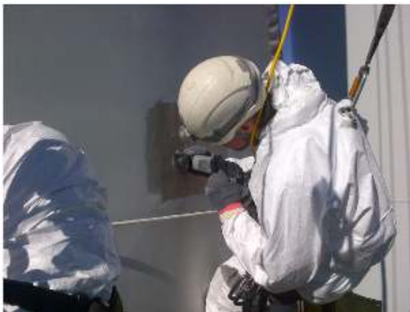
Figura 08 – Reparo Externo de pá de um aerogerador Fonte: GBTECWIND – Inspeção e reparo de pás eólicas Acesso em 27 de Março de 2024
