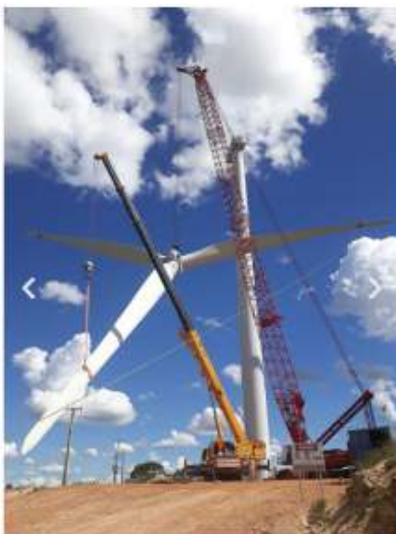
Figura 01 – Subida e instalação de um conjunto de pás. Fonte: BSM Engenharia S.A – Disponível em https://bsm.com.br/inicio/eolica/ Acesso em 16 de Março de 2024
