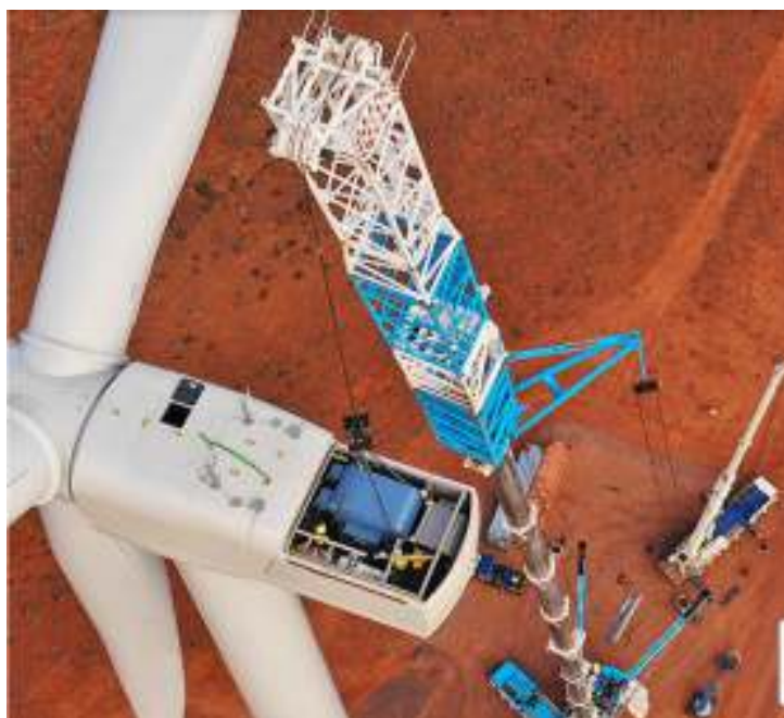
Figura 18 – Troca de um Gerador Elétrico em turbina eólica Fonte: Marxservices – Disponível em https://maxservices.com Acesso em 14 de Abril de 2024
