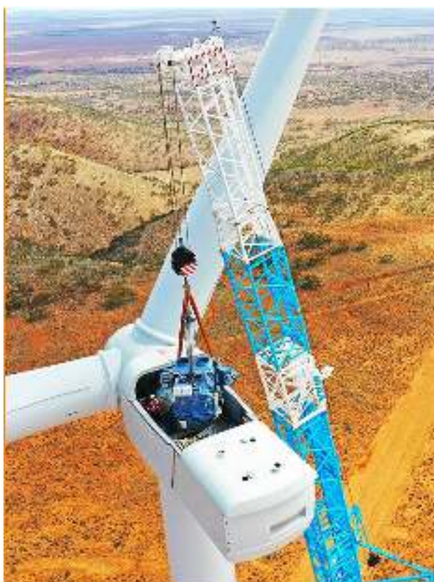
Figura 10 – Substituição de uma Gear Box Fonte: MAX SERVICES – Disponível em https://maxservices.com.au/ Acesso em 29 de Março de 2024
