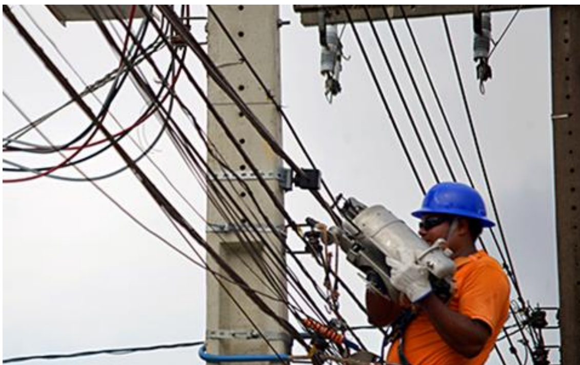
Figura 18– Lançamento de Cabo Óptico
