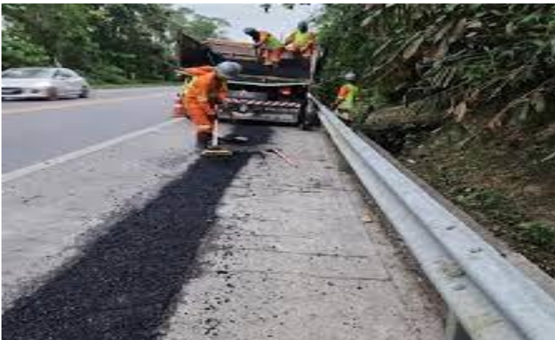
Figura 17– Fechamento da Vala
