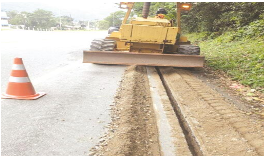
Figura 15– Abertura da Vala
