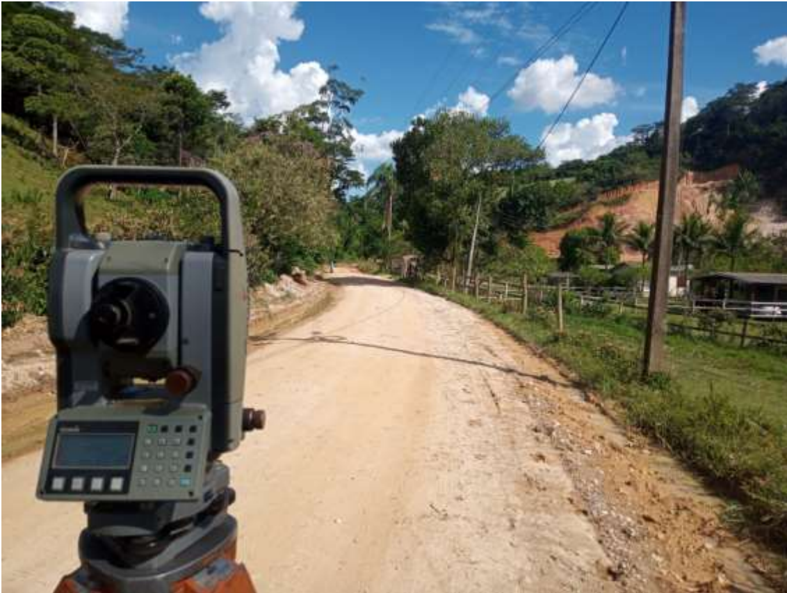
Fotos Registrada em Campo ESTAÇÃO TOTAL ( Ft. 03)
