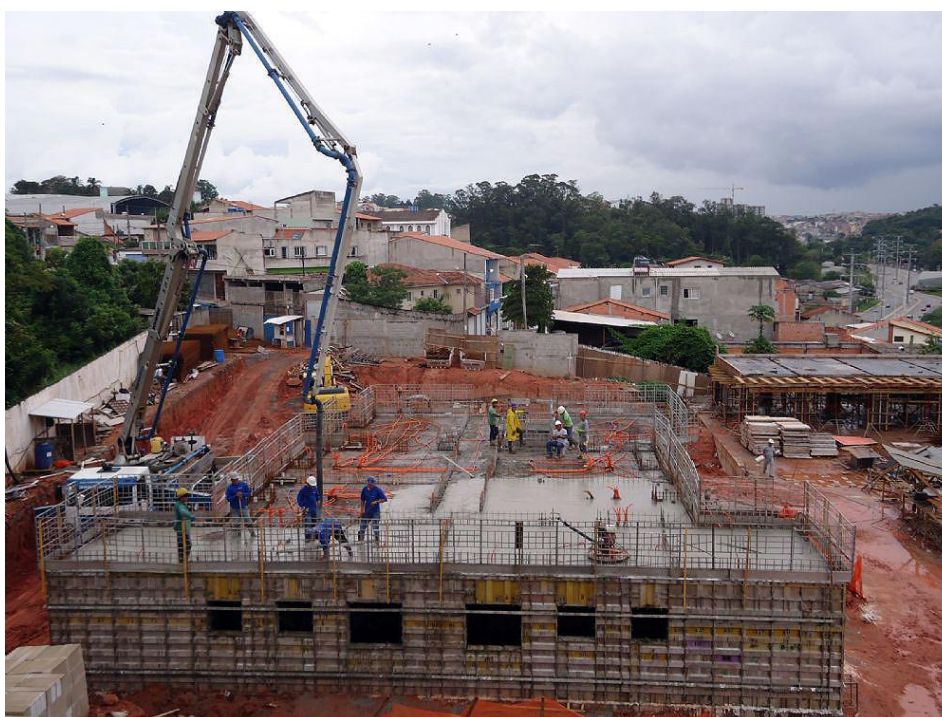
Figura 1 – Exemplo de edifício sendo construído no sistema parede de concreto
