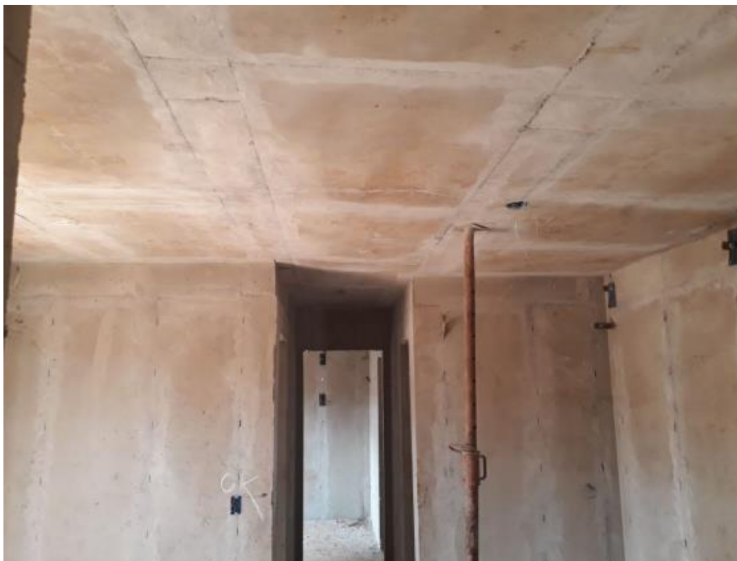
Figura 10 – Acabamento da parede de concreto
