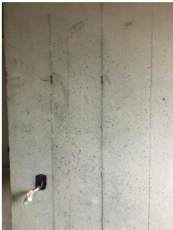
Figura 22 – Parede com superfície porosa e áspera
