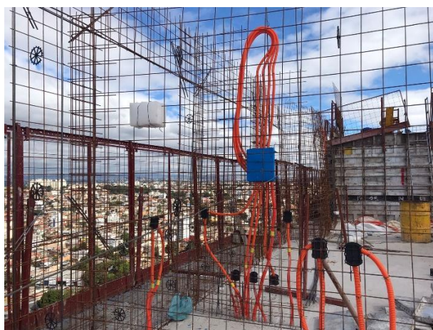
Figura 3 – Posicionamento da armadura
