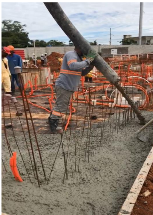
Figura 8 – Lançamento do concreto
