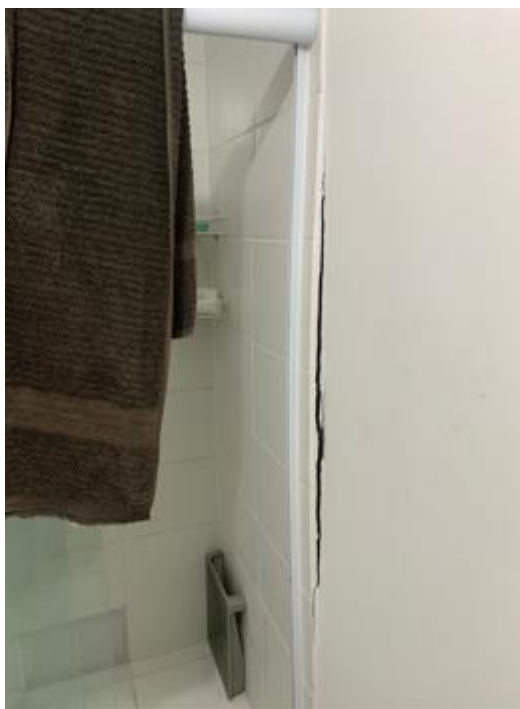
Figura 14 – Deslocamento cerâmico na parede
