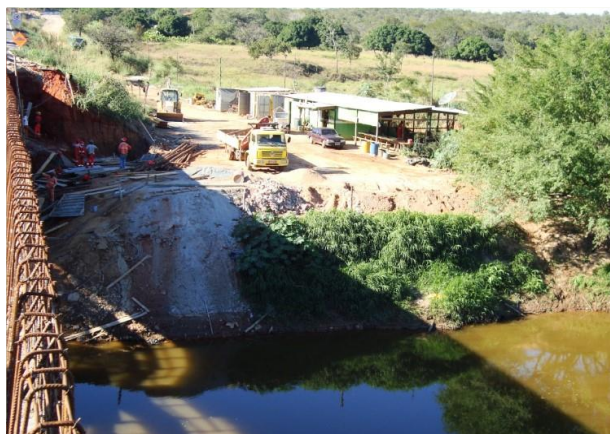
Figura 14: Contaminação de água, pelo lançamento de resíduos em curso d'água. Fonte: arquivo pessoal/2014
