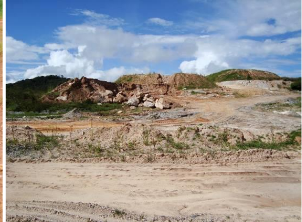
Figura 07: Formação de taludes acentuados com consequente intensificação de processos erosivos durante o período chuvoso, com ravinamento de taludes e carreamento de sedimentos para áreas a jusante. Fonte: arquivo pessoal/2012
