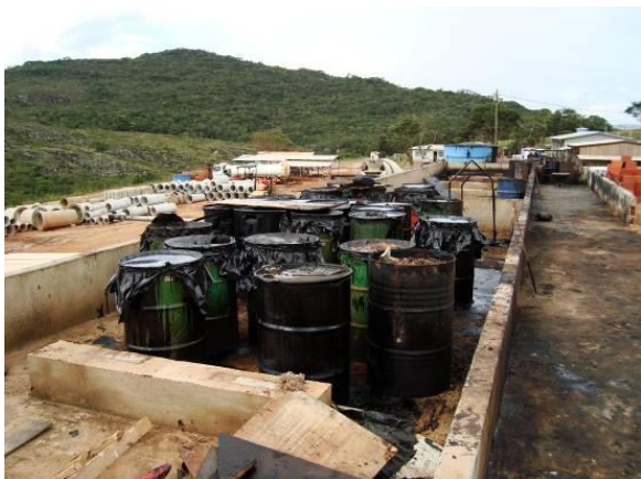
Figura 13: Contaminação do solo, pelo depósito de material contaminado em local inadequado. Fonte: arquivo pessoal/2023
