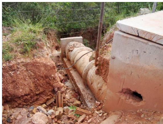
Figura 13: Direcionamento das águas pluviais para ravina existente, favorecendo o desenvolvimento de processos erosivos de grande magnitude. Fonte: arquivo pessoal/2012
