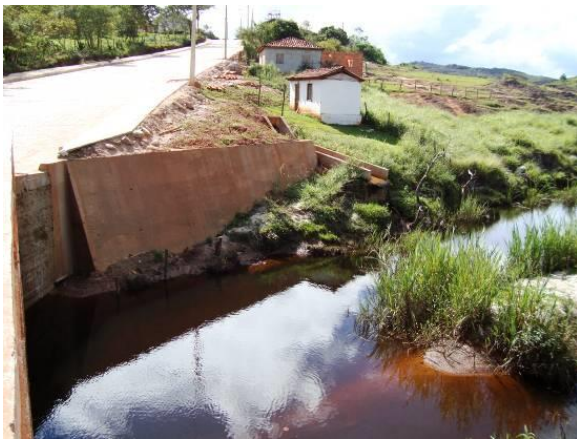
Figura 10: Carreamento de materiais utilizados no assentamento de bloquetes para curso d'água. Fonte: arquivo pessoal/2012
