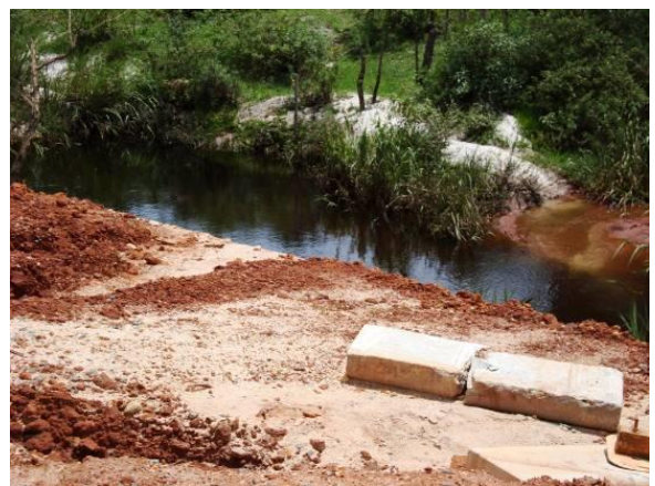
Figura 11: Carreamento de areia utilizada para assentamento de bloquetes para sistema de drenagem pluvial com deságue em curso d'água. Fonte: arquivo pessoal/2012
