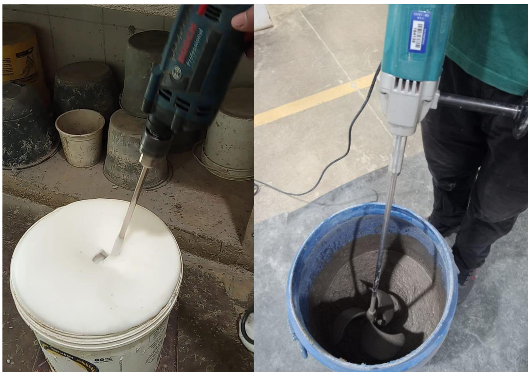
Figura 11 - Mistura mecânica da espuma com a argamassa.
