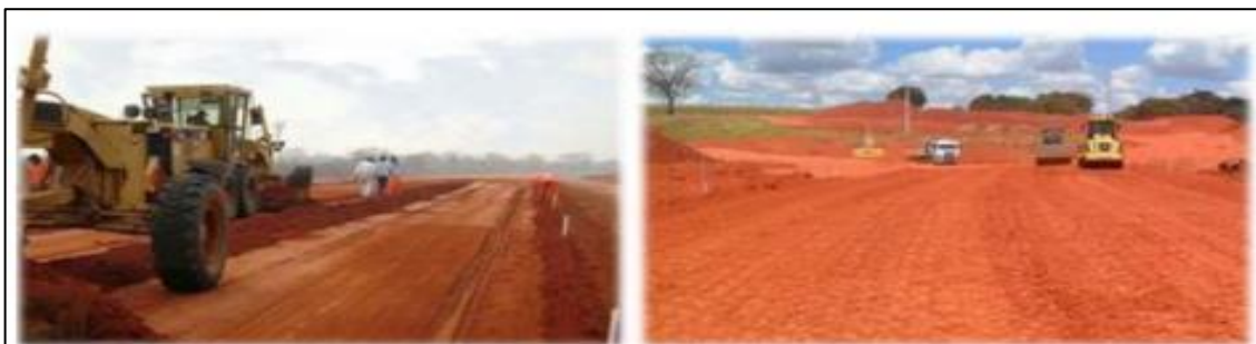
Figura 9 – Execução do reforço do subleito
