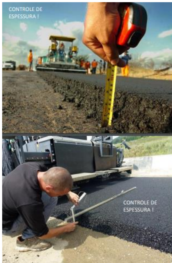
Figura 21 – Controle de espessura
