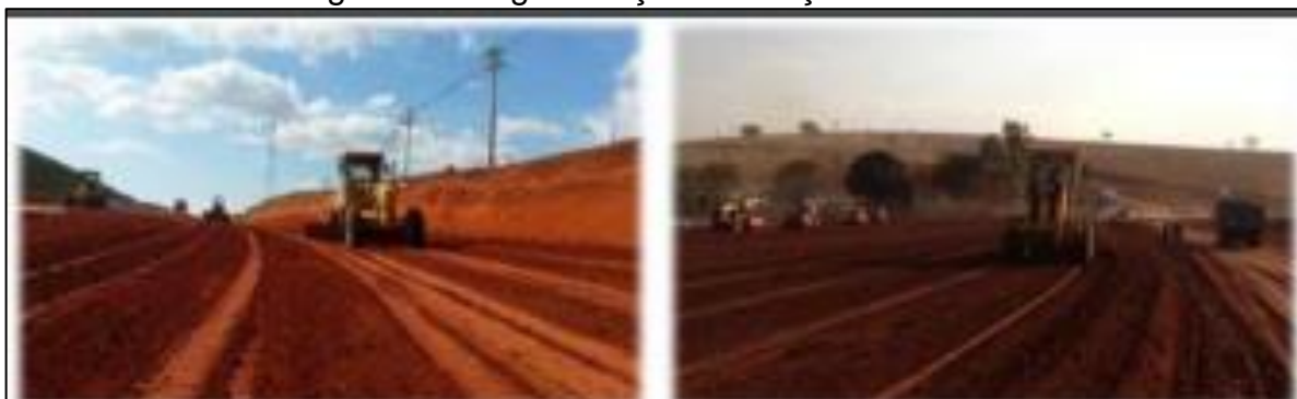
Figura 8 – Regularização e reforço do subleito
