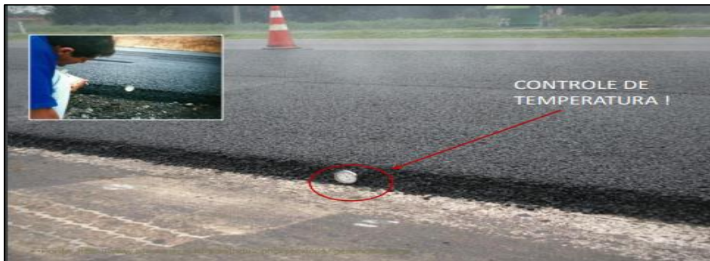
Figura 18 – Controle de execução (CA)
