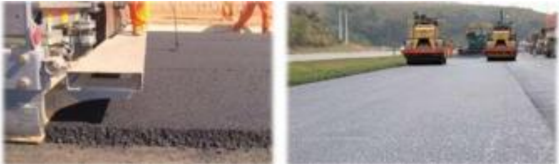
Figura 10 – Revestimento de concreto asfáltico
