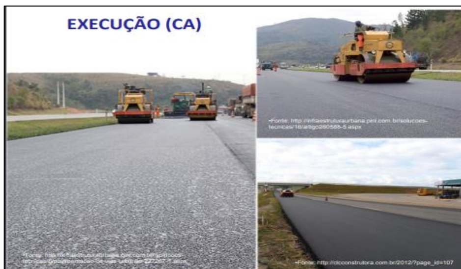
Figura 17 – Execução do CA
