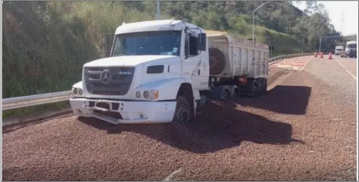
Figura 11 – Rampa de Escape – Carreta Utilizou a Rampa de Escape no dia 10/04/2023 – Brasil Minas Gerais - Anel Rodoviário Celso Mello Azevedo, 5046 - Olhos D'Água Belo Horizonte - MG - (BR-040/MG, km541), Latitude: 19°59'19.20"S, Longitude: 43°58'18.28"O.
