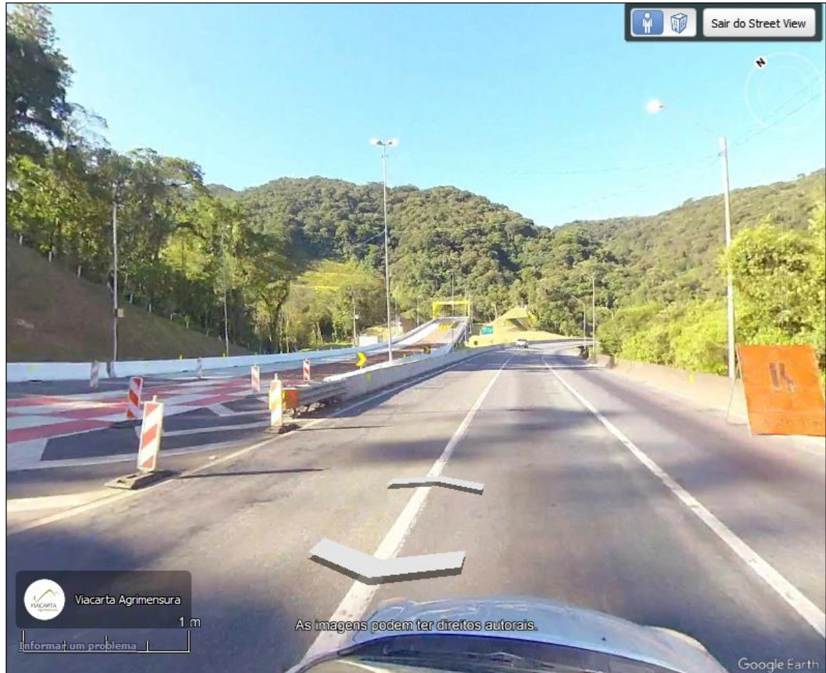
Figura 8 – Rampa de Escape – Greide Descendente – Brasil Paraná - (BR-376/PR, km667), Latitude: 25°51'50.11"S, Longitude: 48°56'14.87"O.
