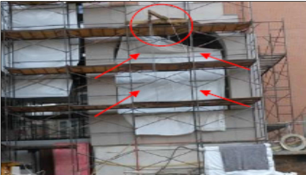
Figura 14 - Içamento ligado a andaime em ambiente externo
