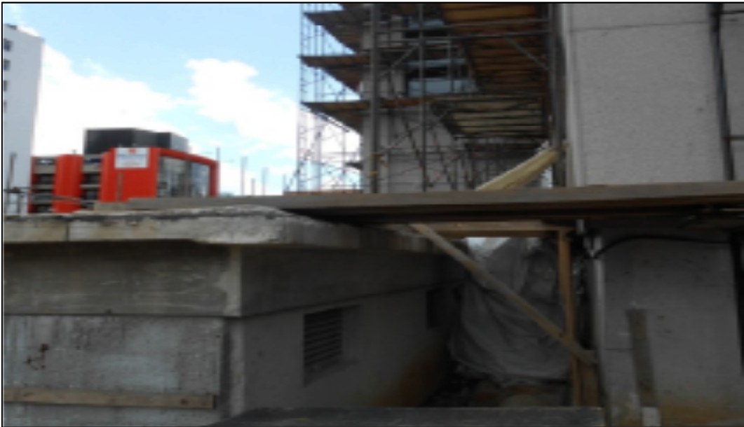
Figura 13 – Andaime apoiado em ambiente externo
