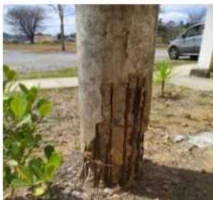
**Figura 3: Corrosão no Pilar 1.**
