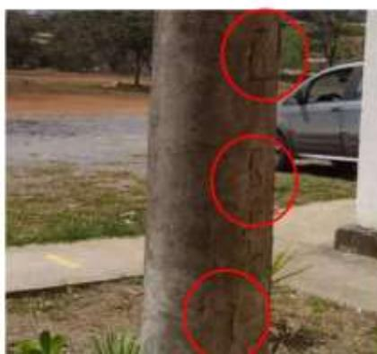
**Figura 5: Fissuras no Pilar 1.**
