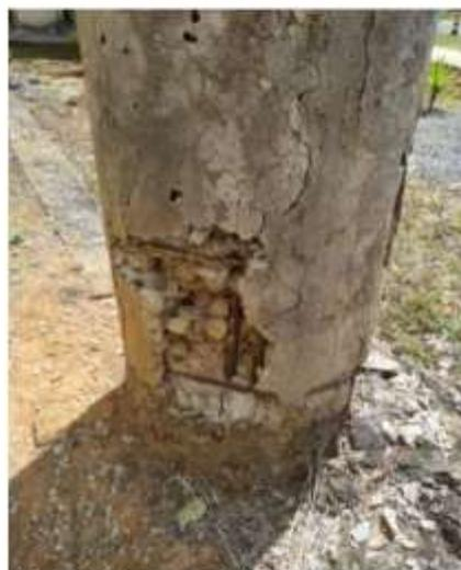
**Figura 7: Corrosão no Pilar 2.**
