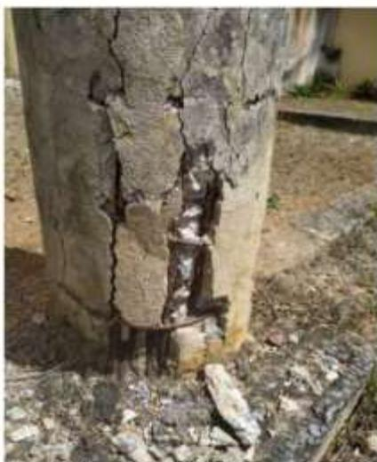
**Figura 6: Corrosão no Pilar 2.**
