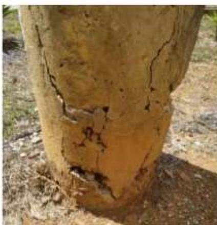
**Figura 8: Fissuras e rachadura no Pilar 2.**
