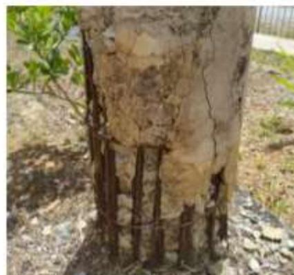
**Figura 4: Corrosão do Pilar 1.**
