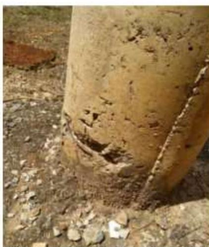
Figura 10: Deslocamento do concreto no Pilar 3.
