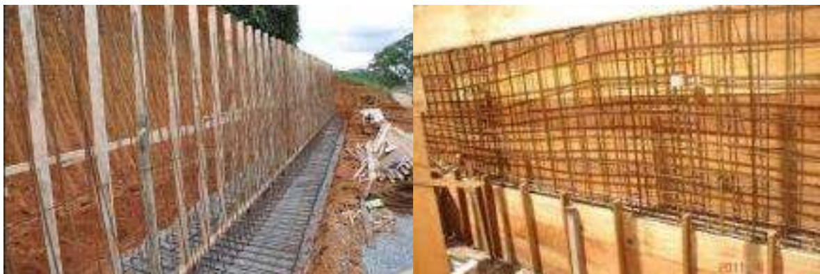
Figura 2.5: Execução de forma e armação – Muro de flexão em concreto
