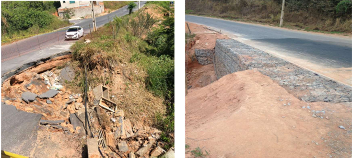
Figura 3.1: Antes e depois da obra
