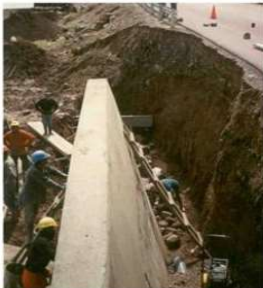
Figura 2.3: Muro de arrimo em concreto armado
