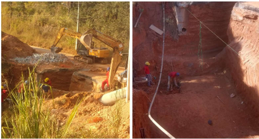
Figura 4.1: Limpeza e escavação do gabião
