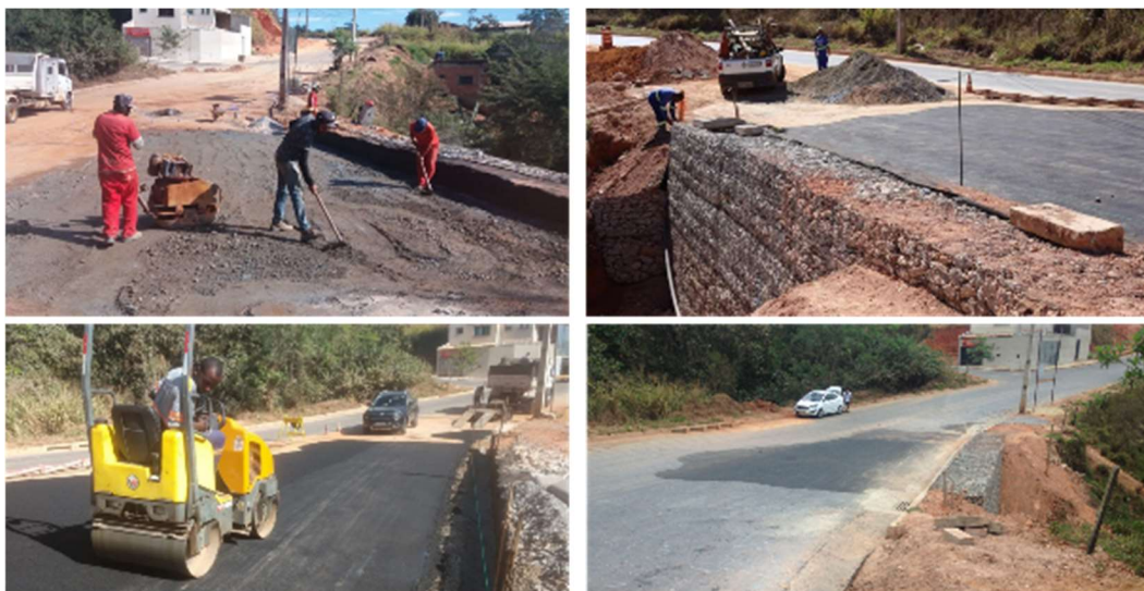
Figura 4.3: Recomposição do asfalto e liberação da via
