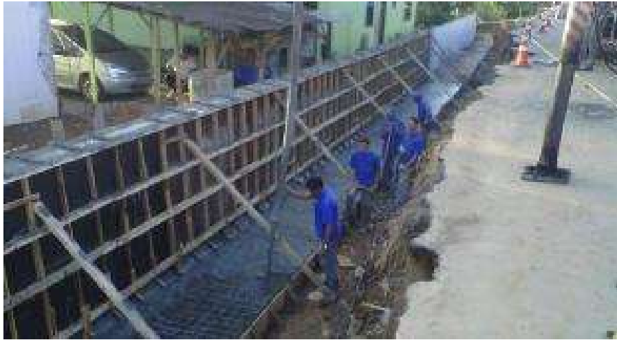
Figura 2.6: Execução da concretagem – Muro de flexão em concreto
