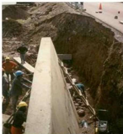
Figura 1: Muro de arrimo em concreto armado
