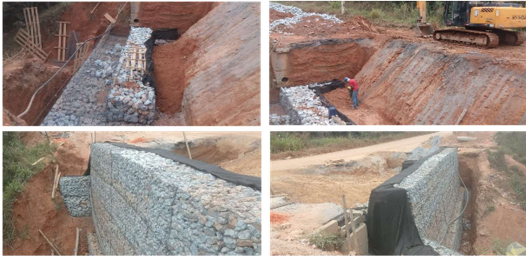
Figura 4.2: Execução do gabião e reaterro
