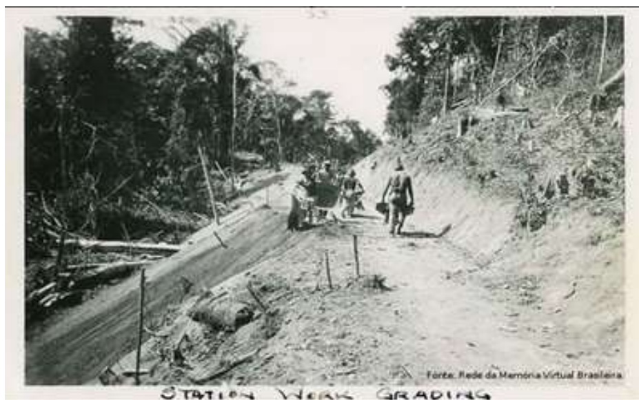
Figura 2.2: Construção Estrada de Ferro Madeira Mamoré
