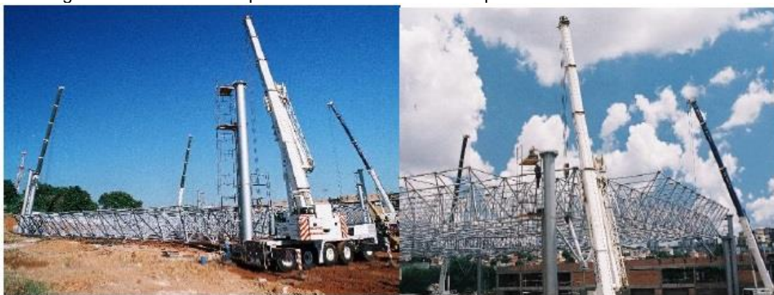
Figura 16: Fotos das Etapas do Método “ lift-slab ” - Expominas - Belo Horizonte - MG
