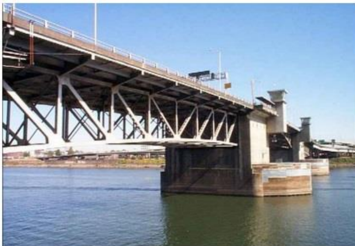
Figura 7: Ponte treliçada com elementos de barra.
