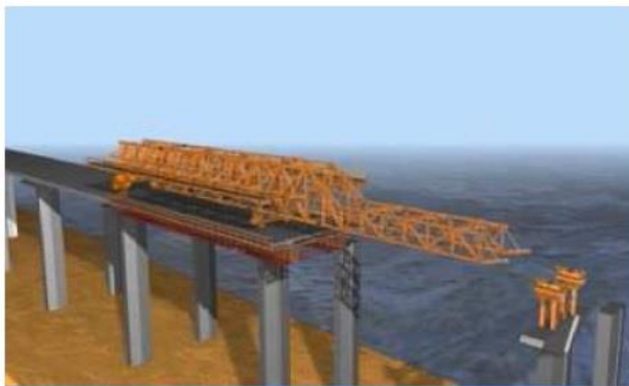
Figura 2: Treliça tridimensional com carrinho de avanço.
