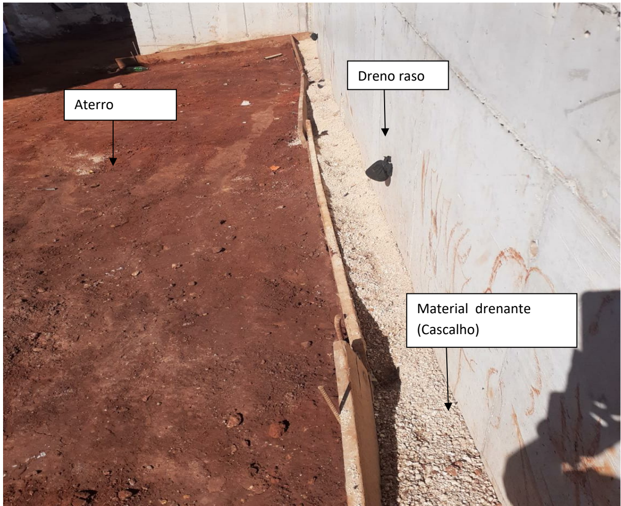
Figura 36: Aterro da contenção
