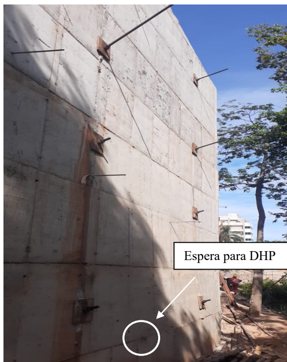
Foto 7: Contenção de concreto armado com espera para DHP. (Cortina atirantada).
