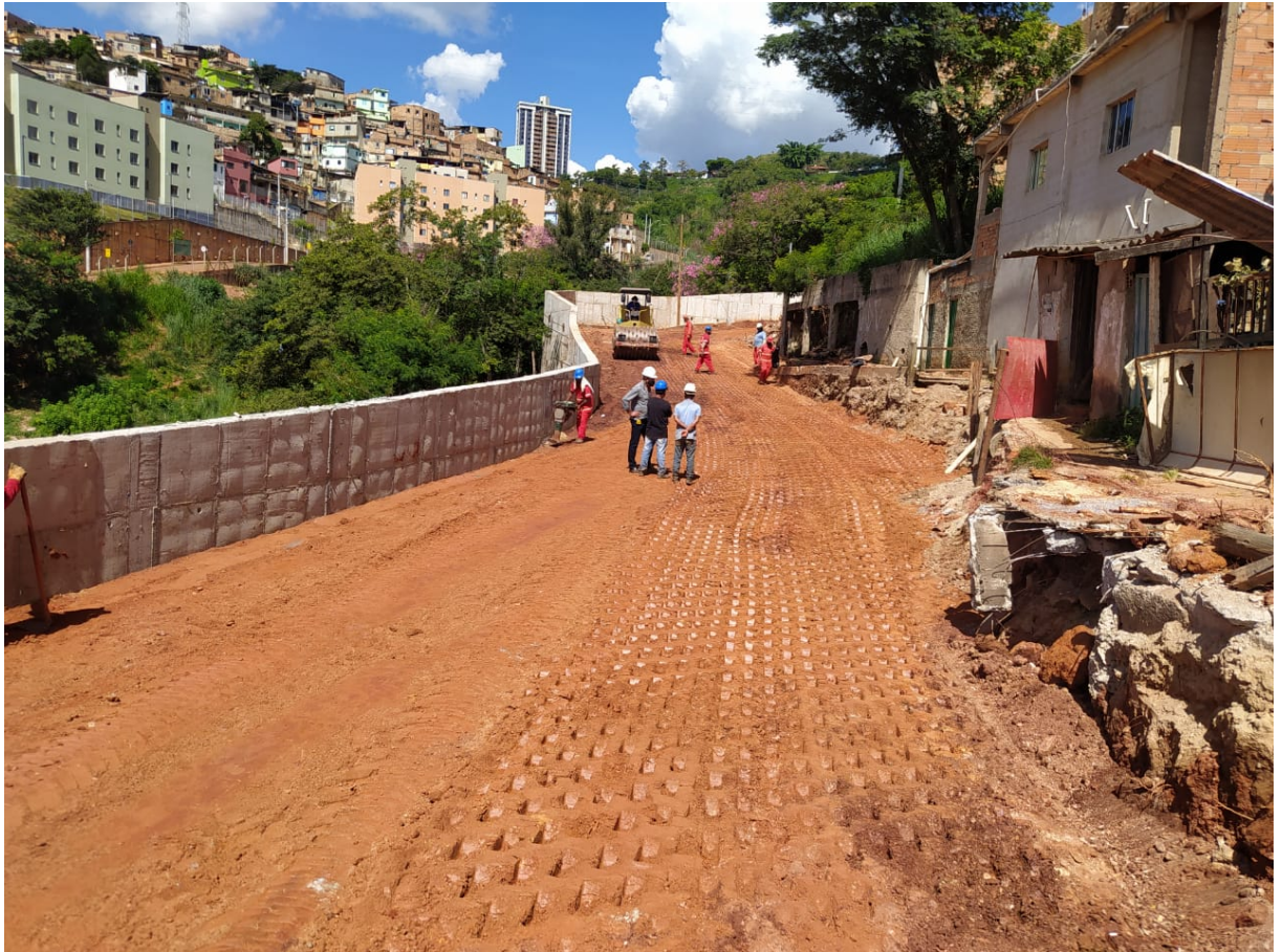
Figura 33: Aterro da contenção
