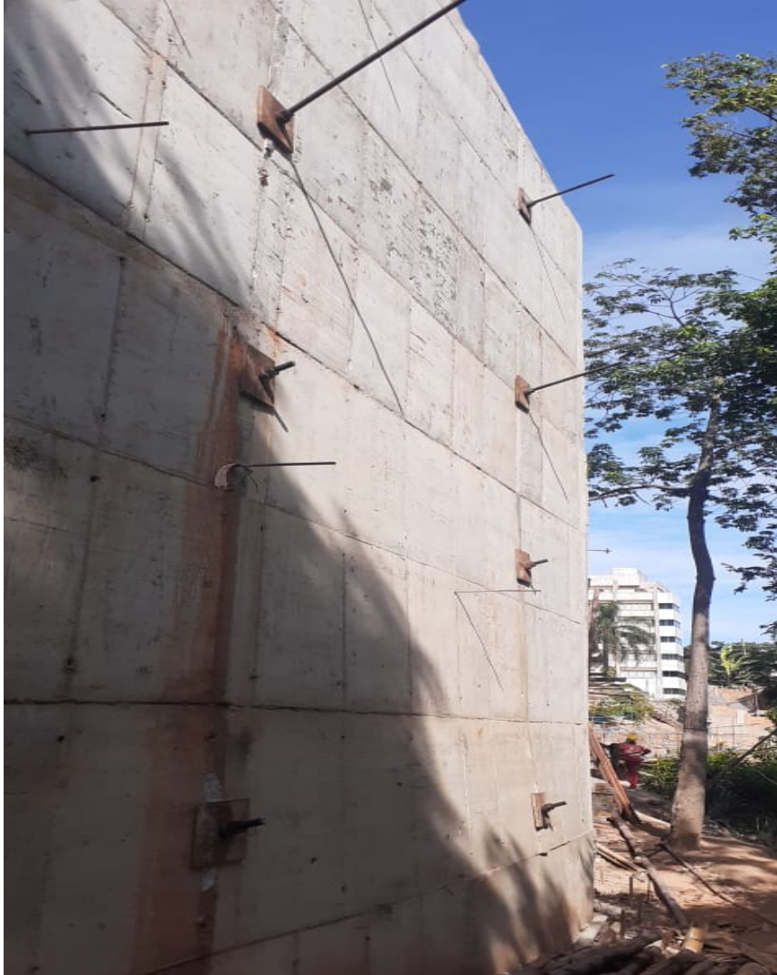
Figura 38- Contenção de concreto armado (cortina atirantada)
