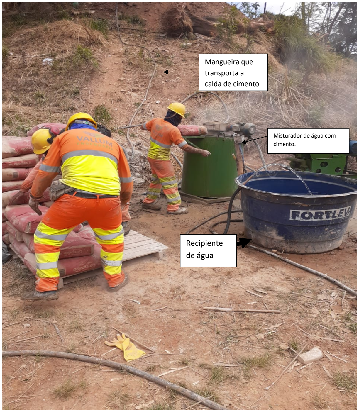
Figura 30: Processo de aplicação de calda de cimento
