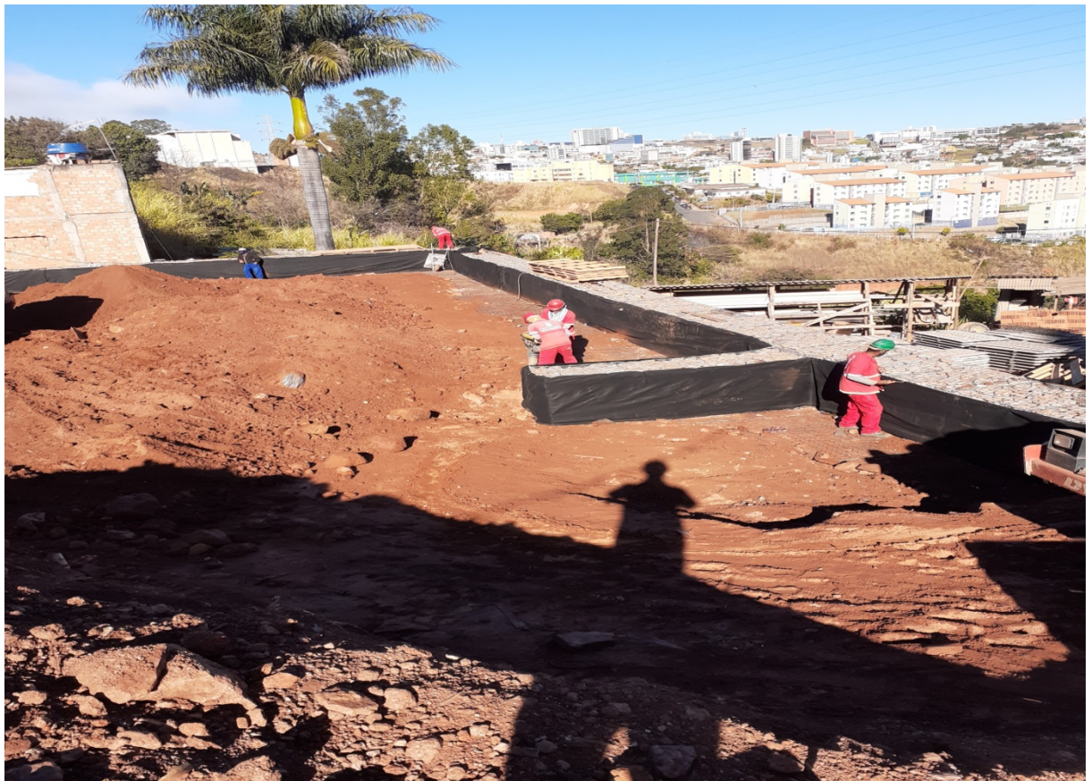
Figura 37- Contenção por gravidade (terramesh)
