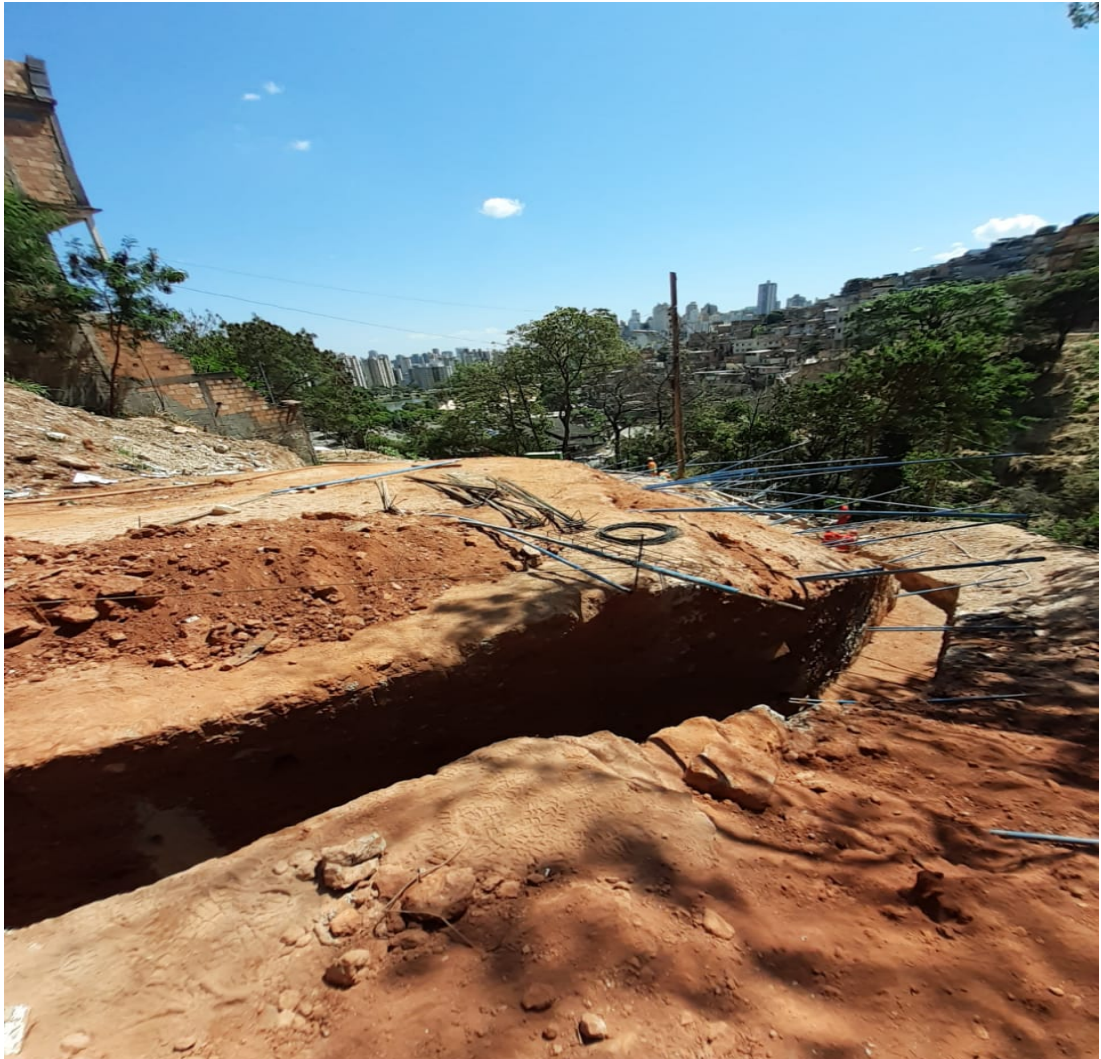
Figura 29: Instalação dos tirantes
