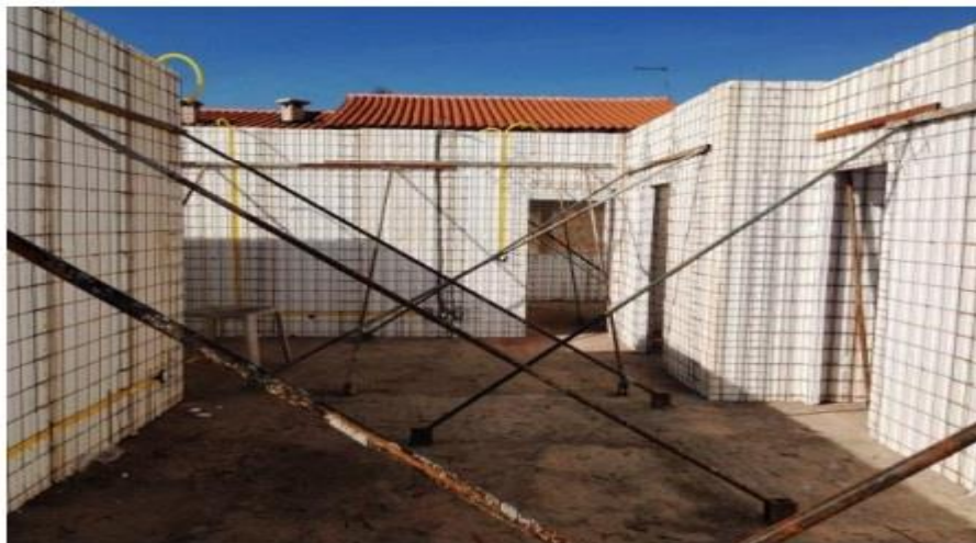
Figura 11 – Painéis alinhados com escoras e régua.
