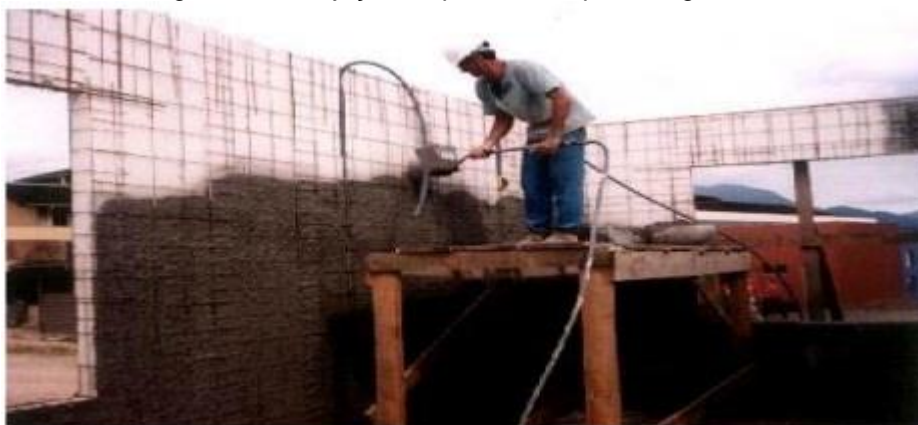
Figura 14 – Projeção da primeira etapa da argamassa
