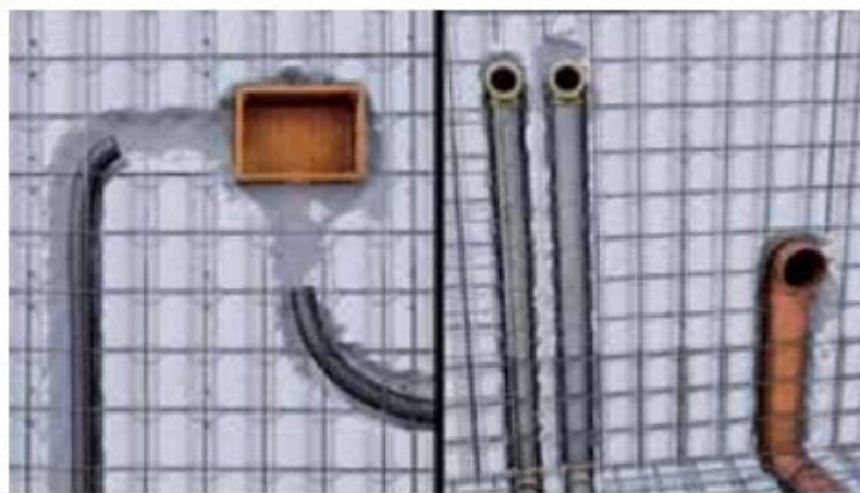
Figura 13 – Instalações elétricas e hidráulicas.
