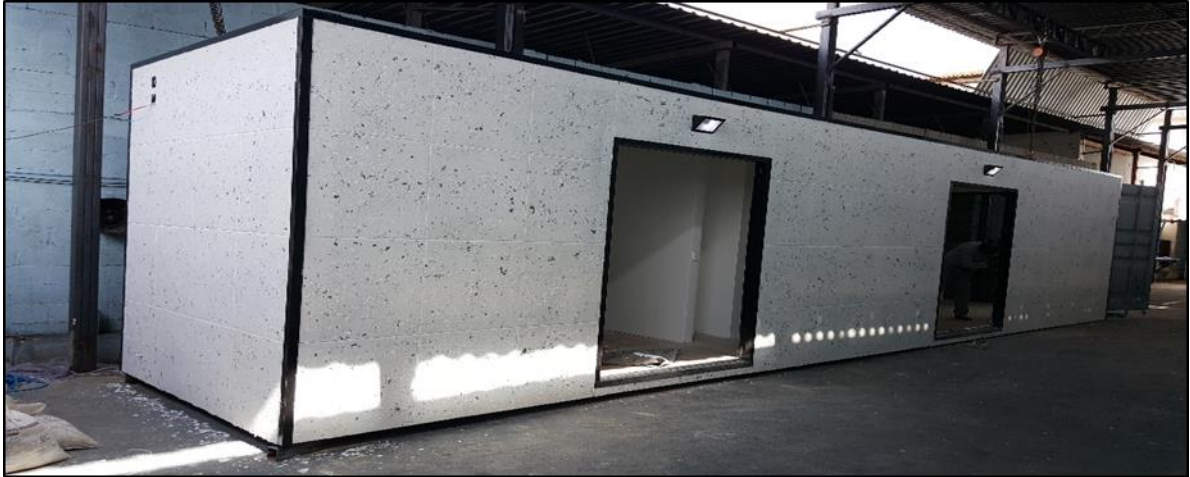
Figura 11 - Revestimento externo em Ecogranito
