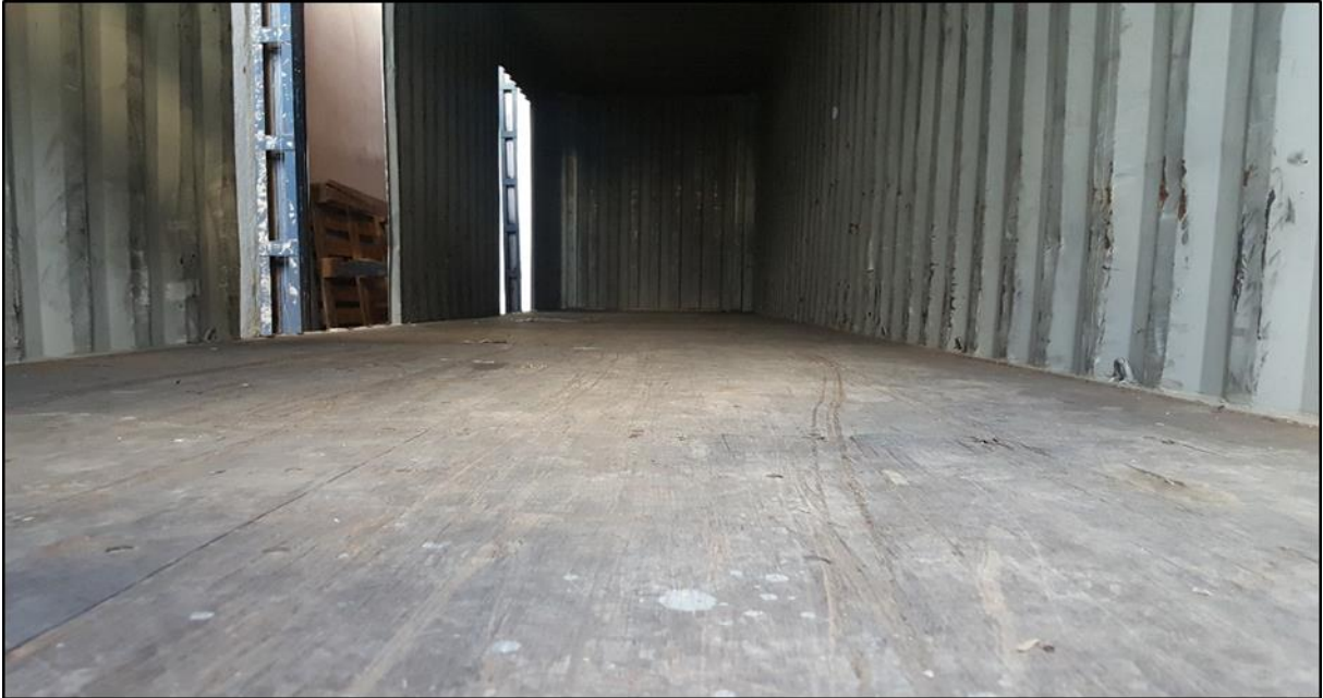
Figura 13 - Piso existente CM antes do tratamento
