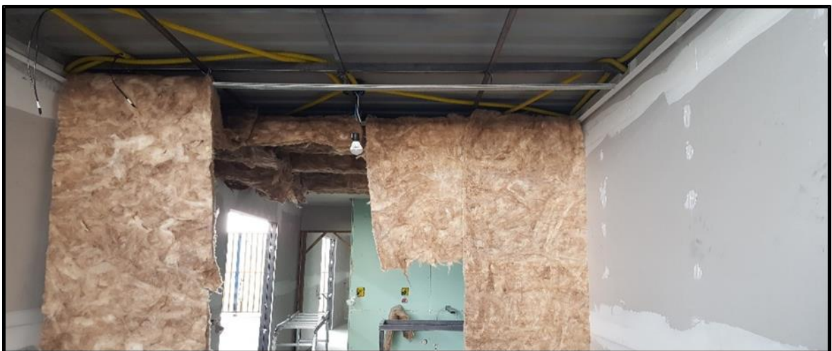
Figura 09 - Isolamento termo acústico do CM
