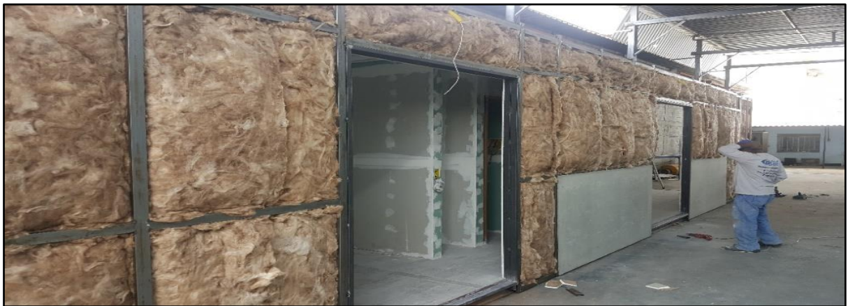
Figura 10 - Isolamento termo acústico externo
