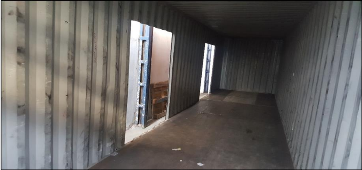
Figura 06 - Abertura de vãos no CM
