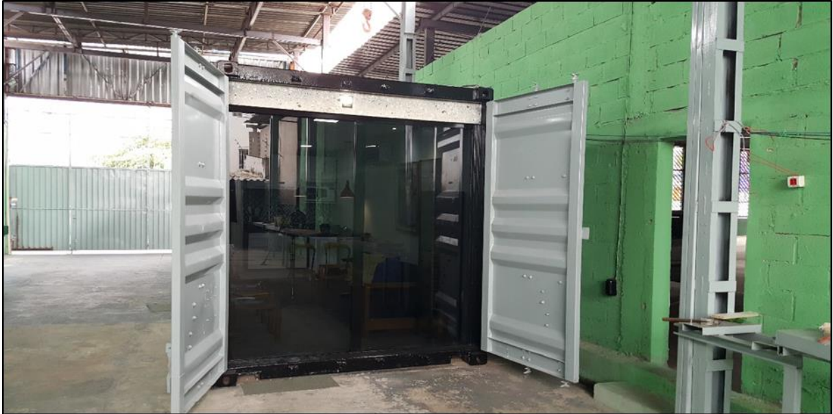
Figura 12 - Fechamento em vidro temperado
