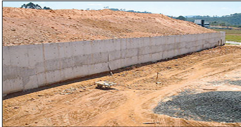
FIGURA 5 - Muro de Arrimo. Fonte: Schramm (2016).
