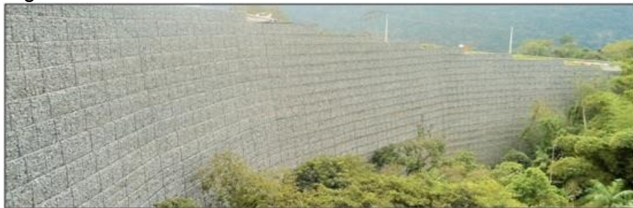
Figura 5 - Estrutura Terramesh®
