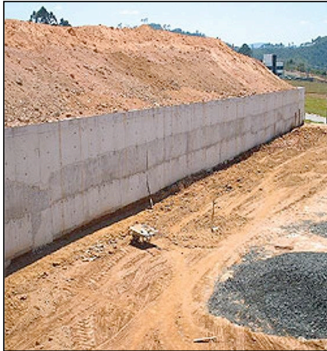
Figura 6 - Muro de Arrimo
