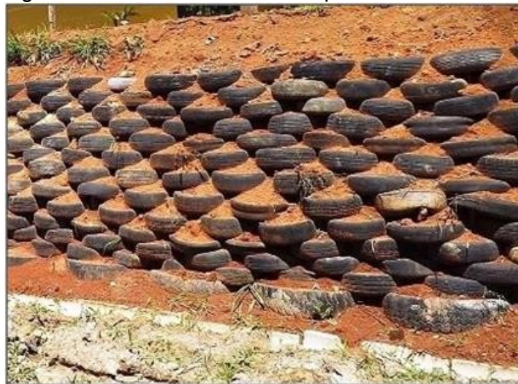
Figura 7 - Estrutura em muro de pneus
