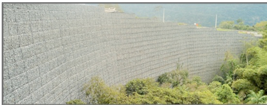
FIGURA 4 - Estrutura Terramesh ® . Fonte: Maccaferri (2016).
