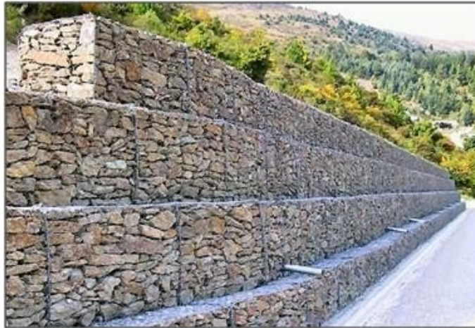
Figura 4 - Muro de Gabião
