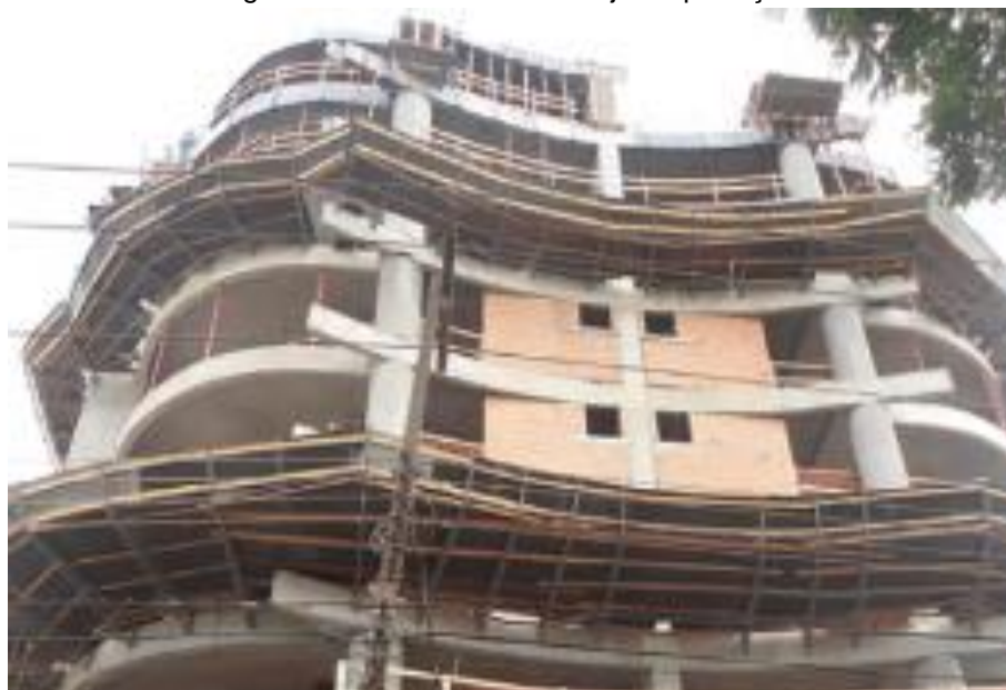
Figura 2 - Plataforma e bandeja de proteção.
