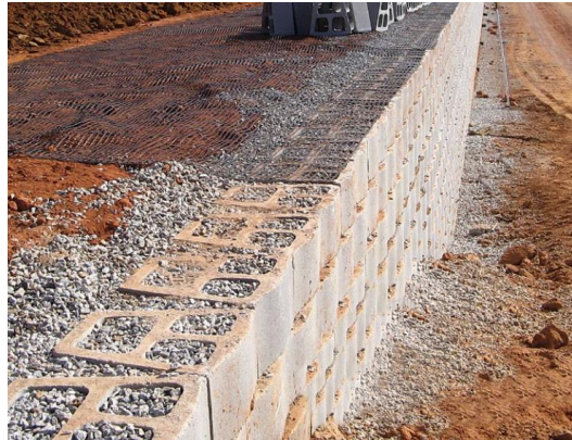
FIGURA 10 - EXECUÇÃO DE MURO TERRAE
