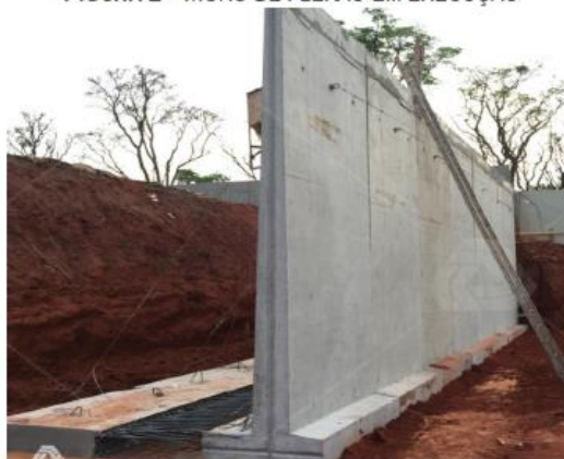
FIGURA 2 - MURO DE FLEXÃO EM EXECUÇÃO
