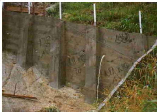
FIGURA 15 - SISTEMAS DE DRENAGEM COM BARBACÃS
