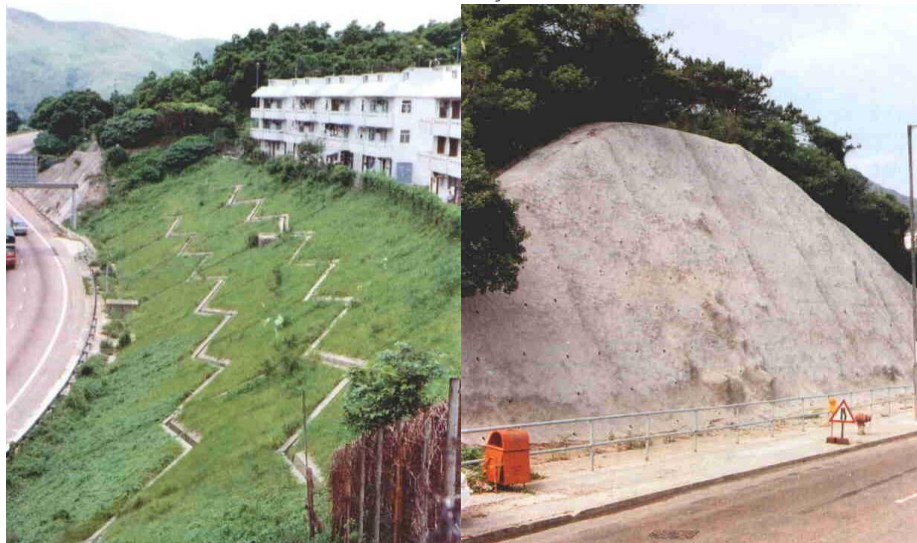
FIGURA 11 - PROTEÇÃO DE TALUDE
