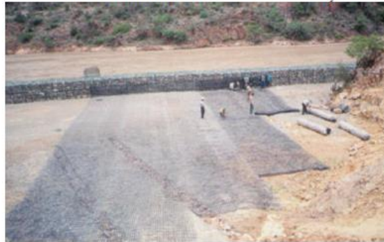
FIGURA 3 – TERRAMESH SYSTEM EM EXECUÇÃO
