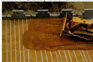
FIGURA 4 – EXECUÇÃO DE TERRA ARMADA
