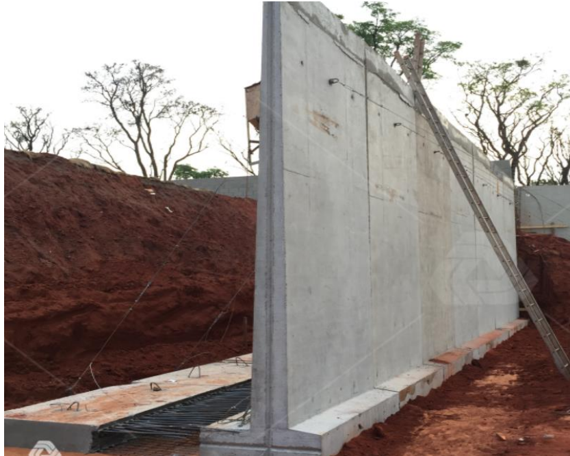
FIGURA 36 - MURO DE FLEXÃO EM EXECUÇÃO
