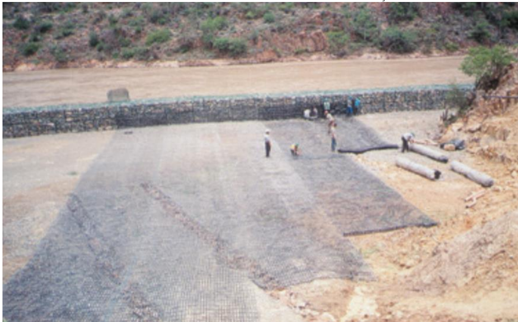
FIGURA 37 – TERRAMESH SYSTEM EM EXECUÇÃO
