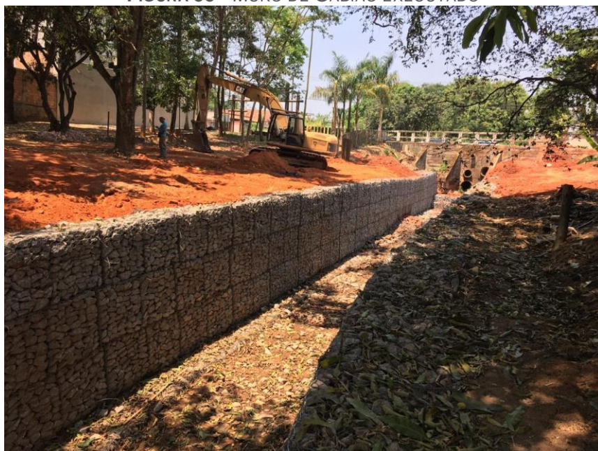
FIGURA 35 - MURO DE GABIÃO EXECUTADO
