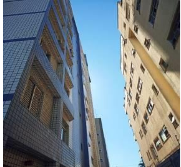
Figura 24 – Fachada lateral esquerda
