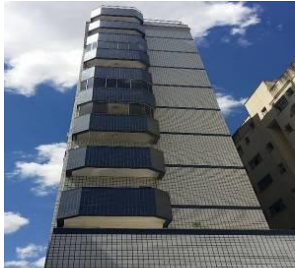
Figura 25 – Fachada dos fundos
