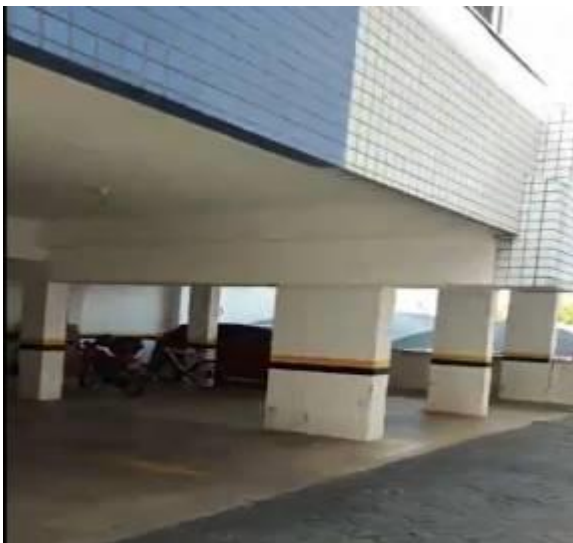
Figura 29 – Vista frontal do pilotis
