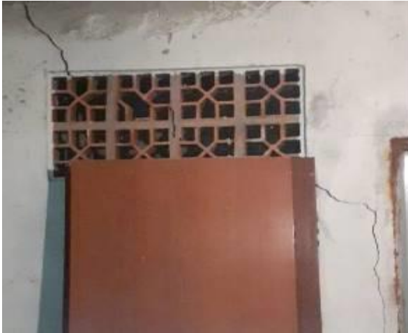
Figura 47 – Banheiro 1 do subsolo 1
