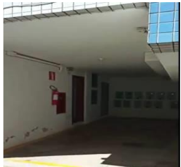
Figura 30 – Vista lateral esquerda do pilotis
