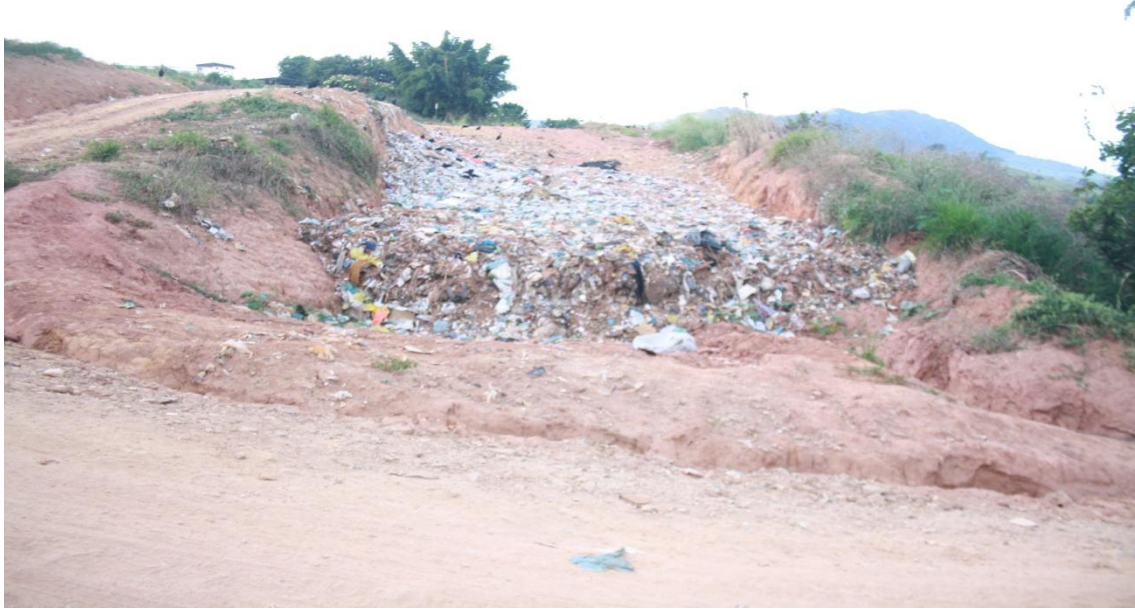
Vala de rejeitos
