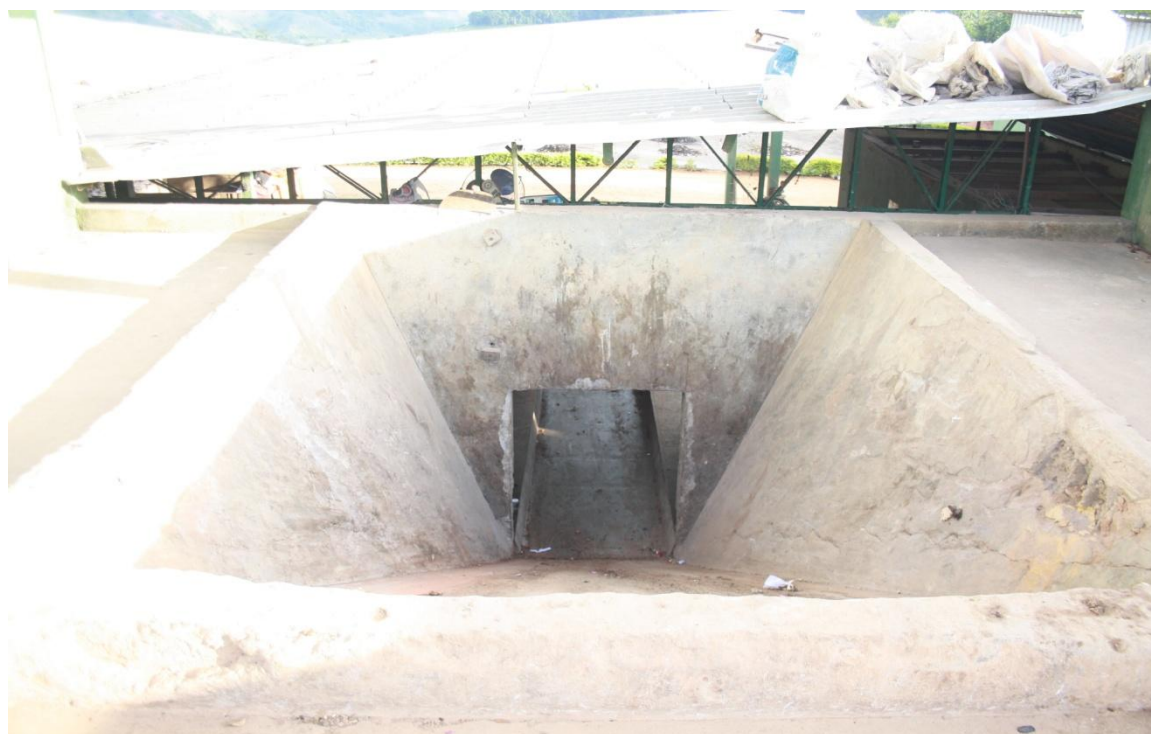
Fosso de descarga de lixo
