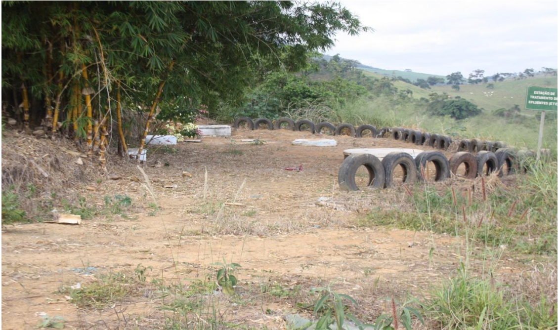
Estação de Tratamento de efluentes da UTCL
