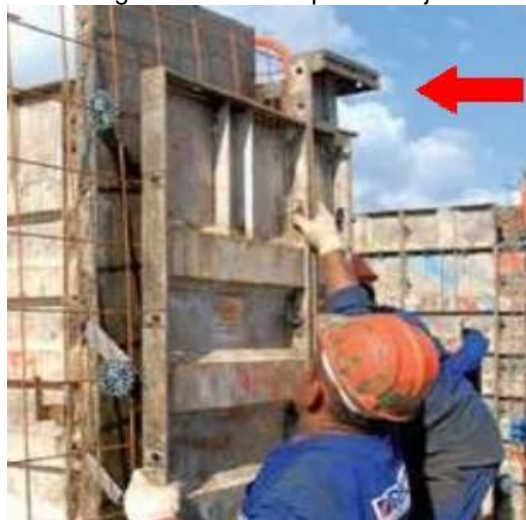
Figura 15 – União parede-laje.
