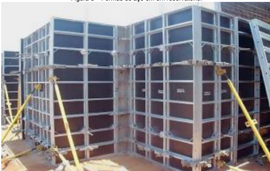
Figura 8 – Fôrmas de aço em um reservatório.
