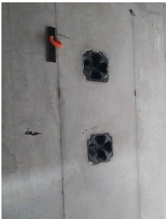
Figura 37 – Espera da instalação elétrica.
