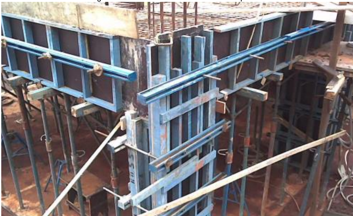
Figura 6 – Fôrmas de madeira revestida pronta.
