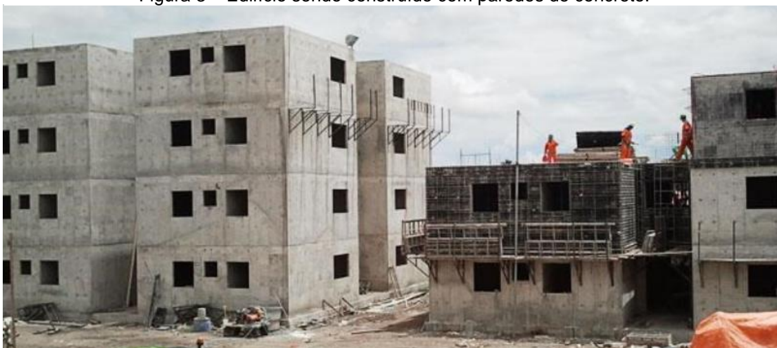
Figura 3 – Edifício sendo construído com paredes de concreto.
