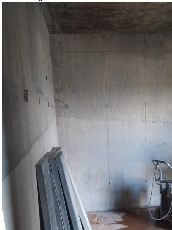
Figura 59 – Juntas de concreto.
