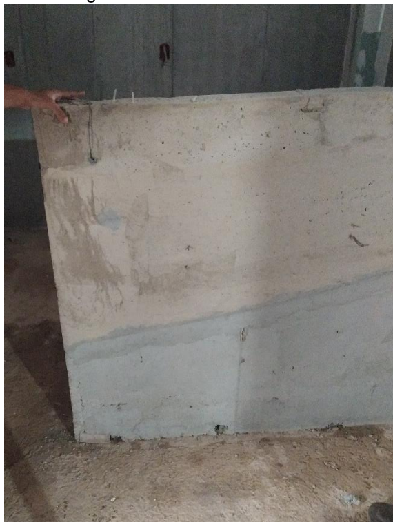
Figura 58 – Juntas de concreto.
