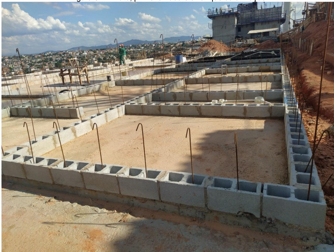
Figura 31 – Platô, primeira fiada e arranque da armação.
