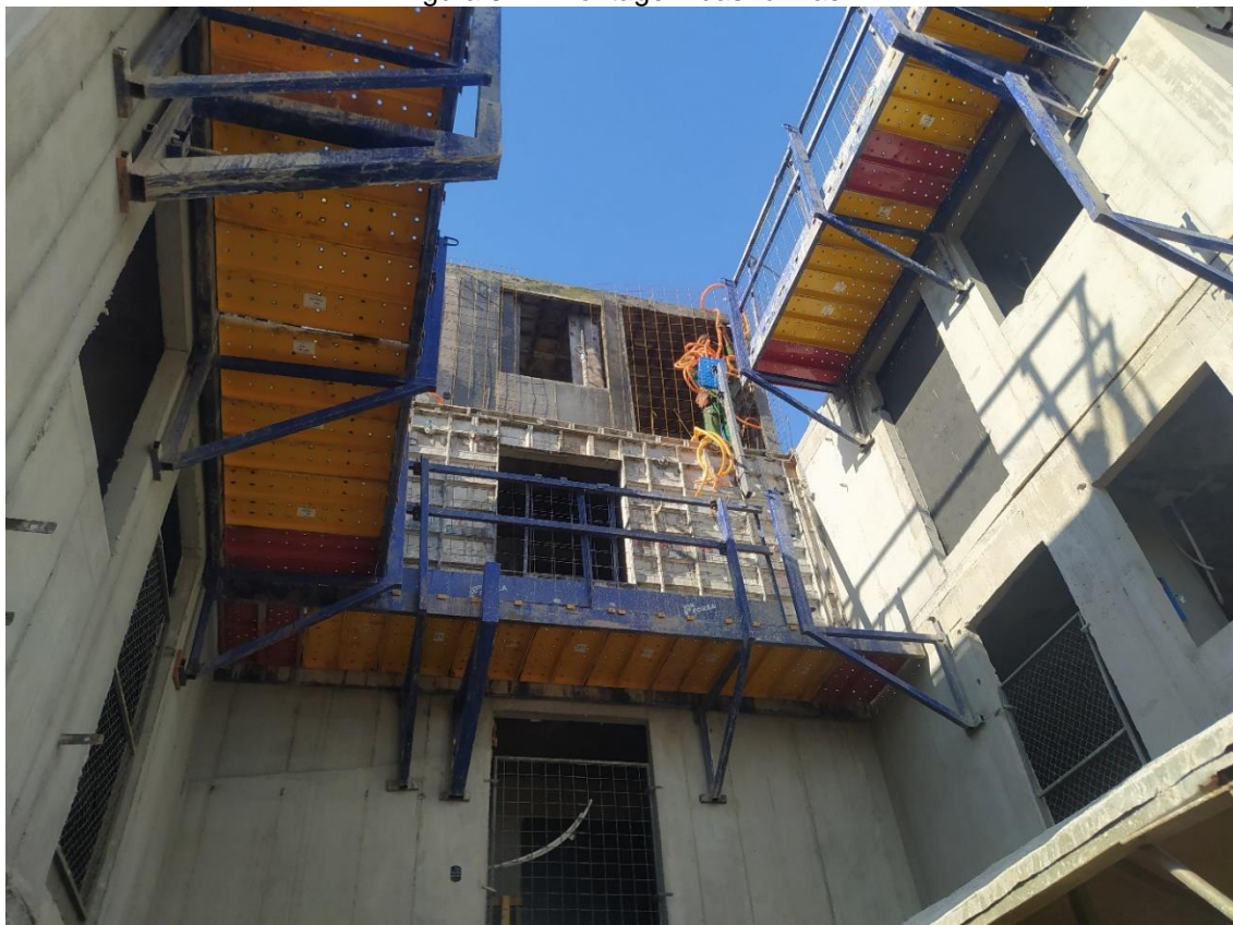
Figura 34 – Montagem das fôrmas.
