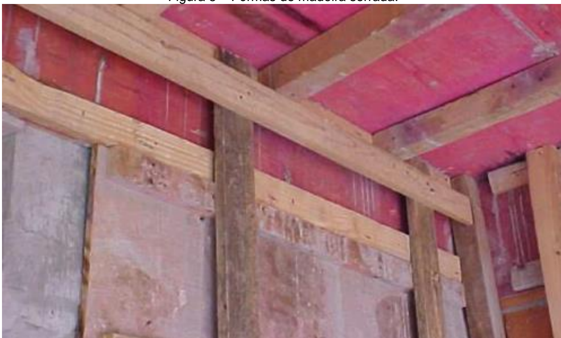
Figura 5 – Fôrmas de madeira serrada.
