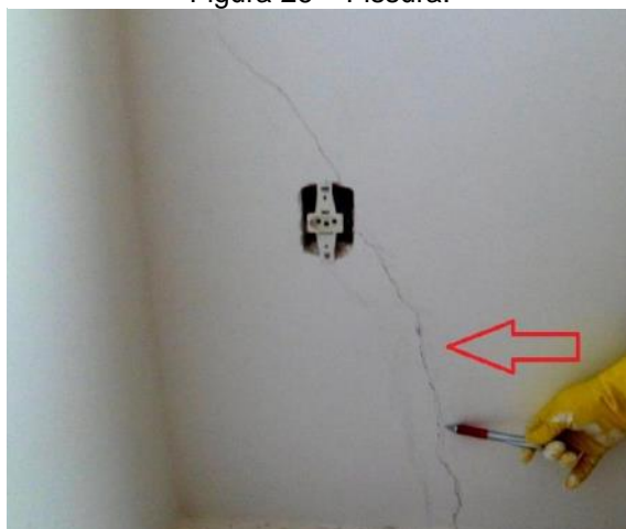
Figura 26 – Fissura.
