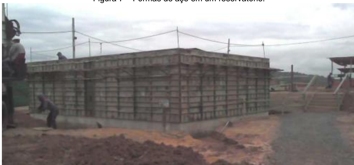
Figura 7 – Fôrmas de aço em um reservatório.
