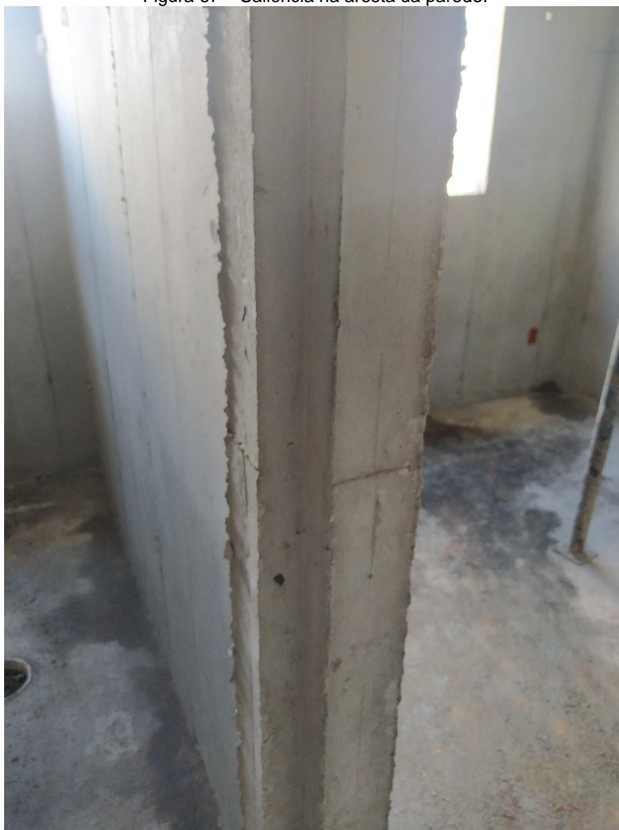
Figura 67 – Saliência na aresta da parede.
