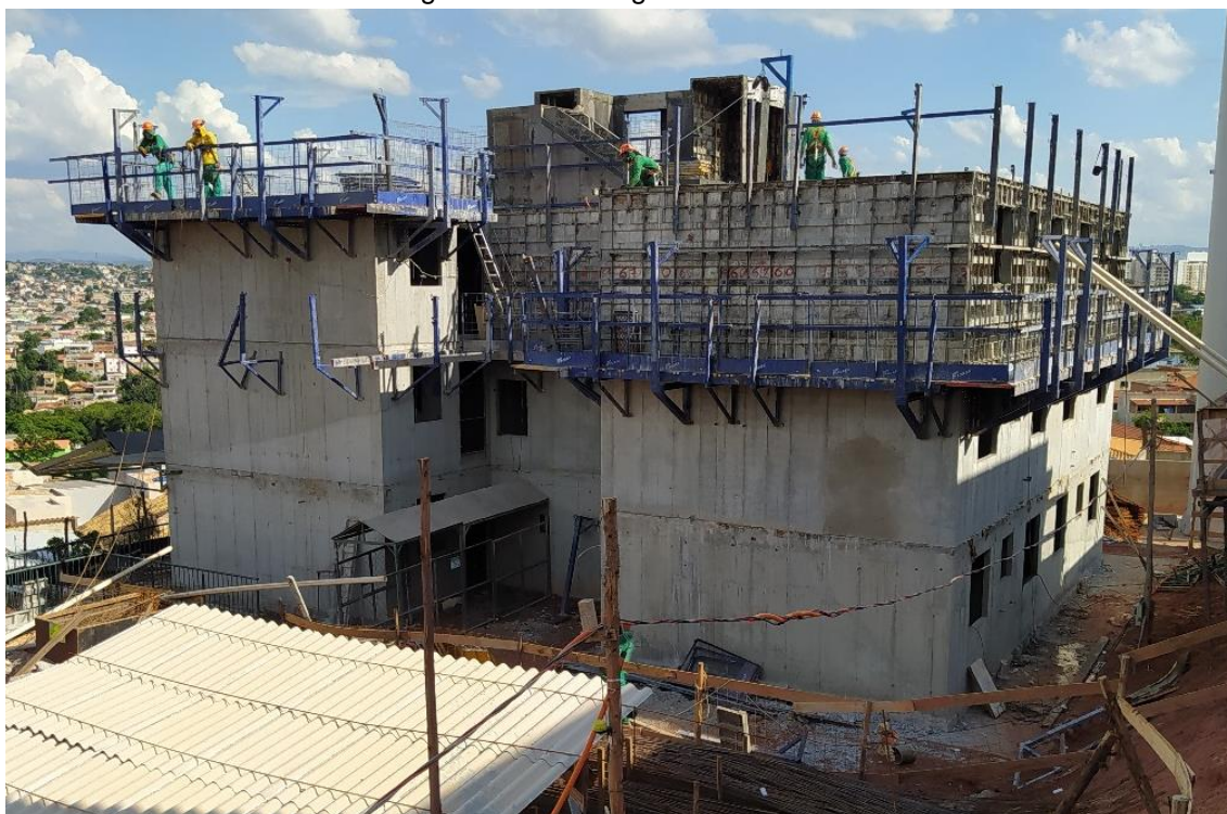
Figura 33 – Montagem das fôrmas.
