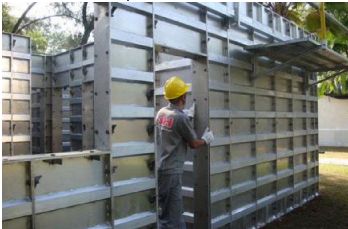
Figura 9 – Fôrmas de alumínio.
