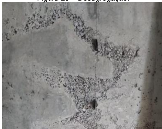
Figura 29 – Desagregação.
