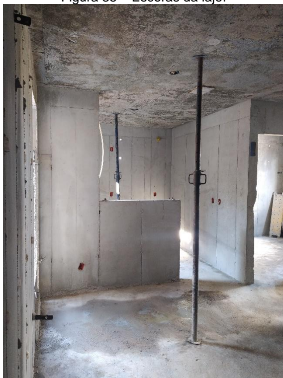
Figura 35 – Escoras da laje.
