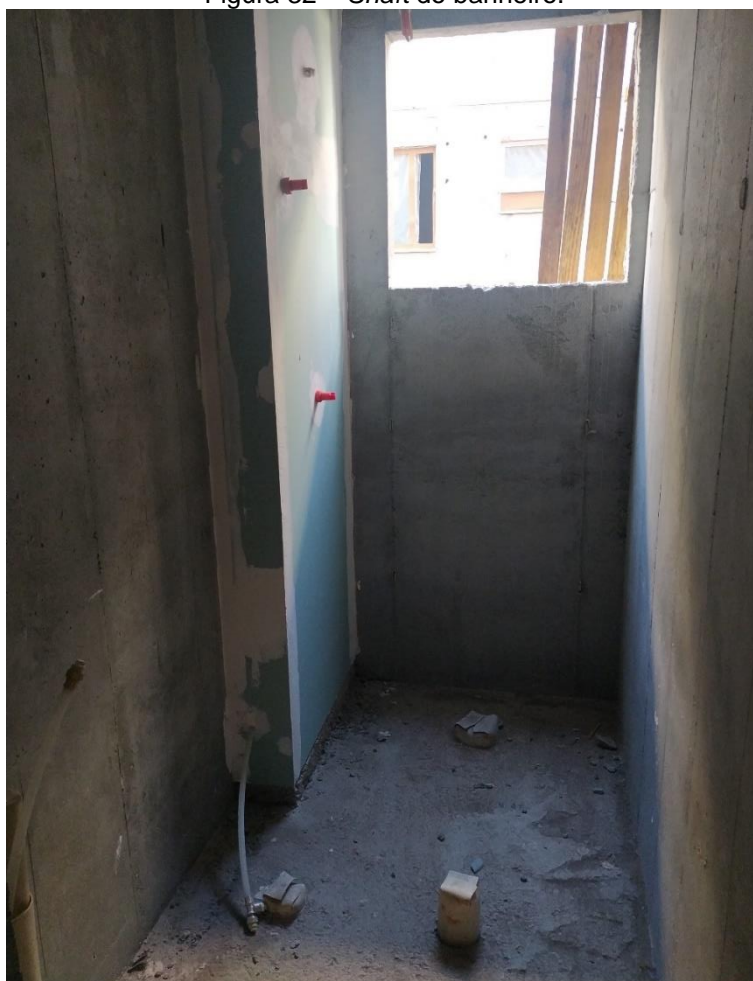
Figura 32 – Shaft do banheiro.
