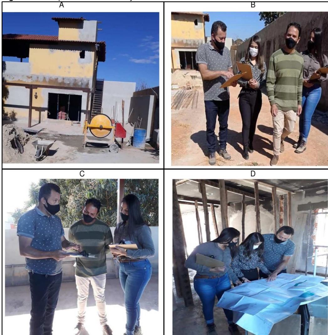
Figura 12 - Etapas sobre a realização da visita técnica no canteiro de obra
