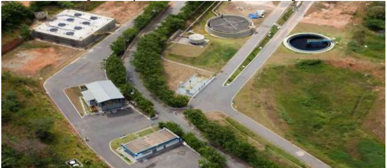
Figura 1: Estação de Tratamento de Esgoto Nova Contagem
