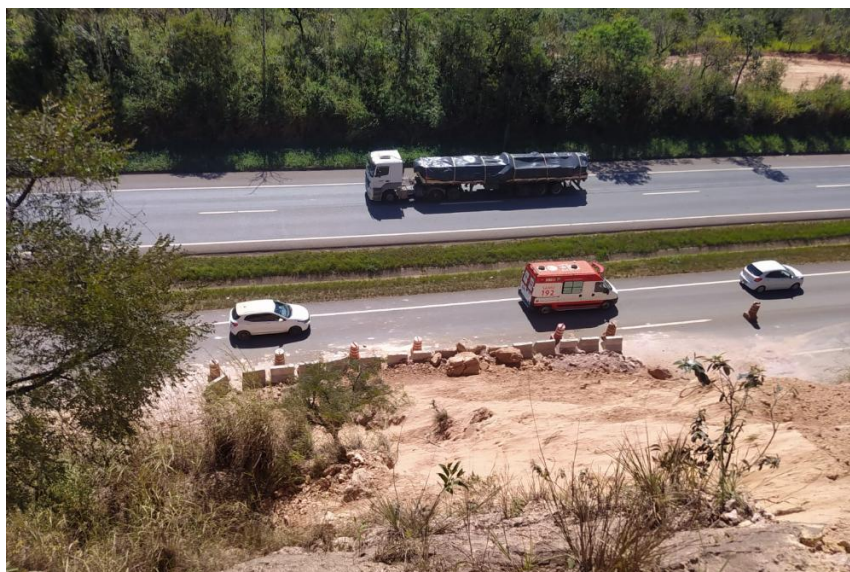
Figura 7 - Deslizamento de terra que invadiu a Rodovia
