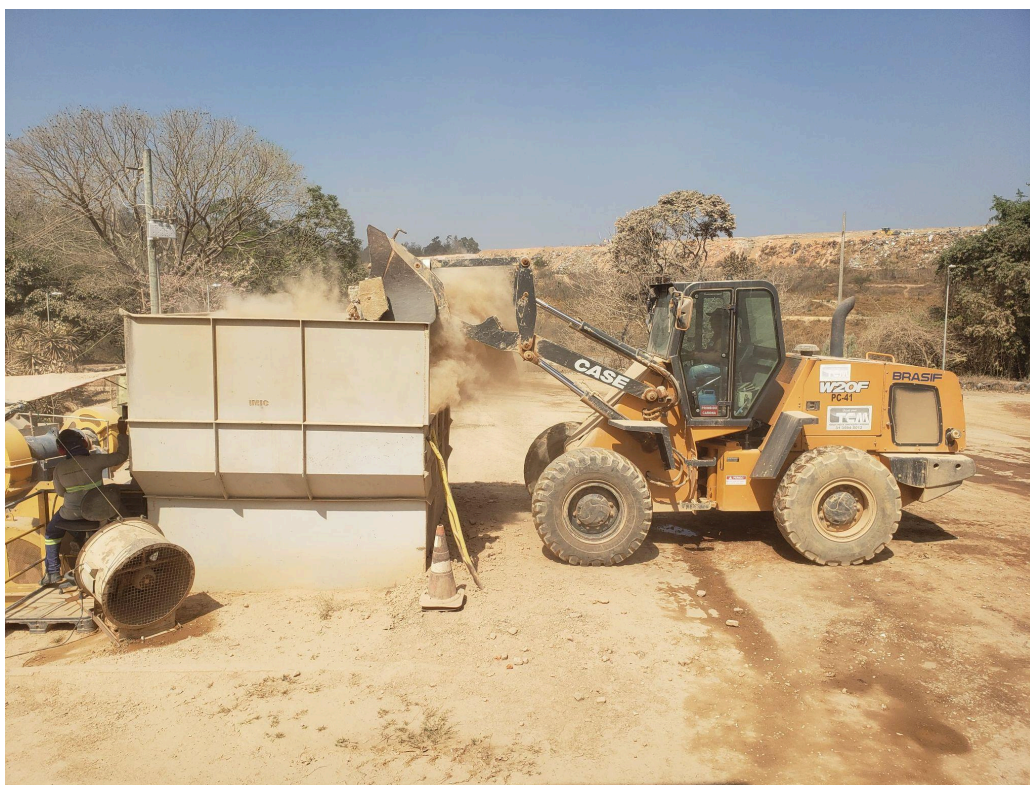
Imagem 5 - Trator colocando material na estação de britagem.
