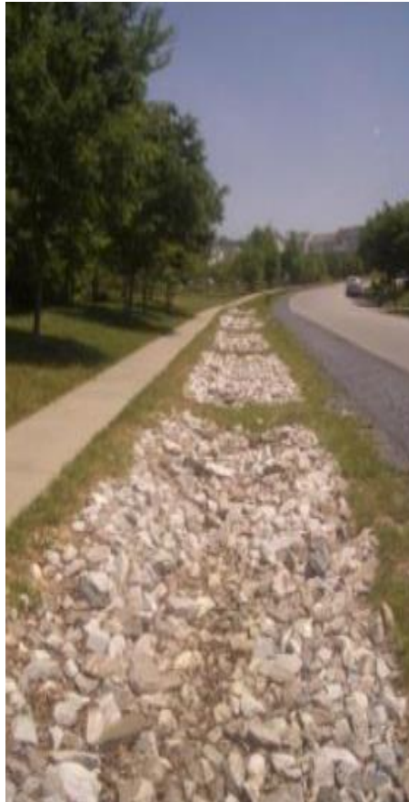
FIGURA 6 – Trincheira de Infiltração
