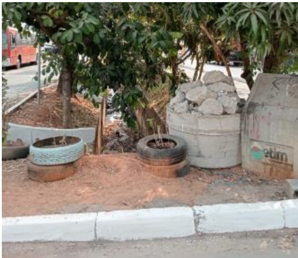
FIGURA 4 – Córrego obras de drenagem com canaleta, pavimentação asfáltica
