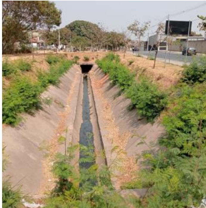
FIGURA 3 - Córrego obras de drenagem com canaleta
